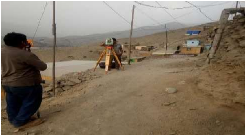
Figura 02: Levantamiento topográfico del talud
