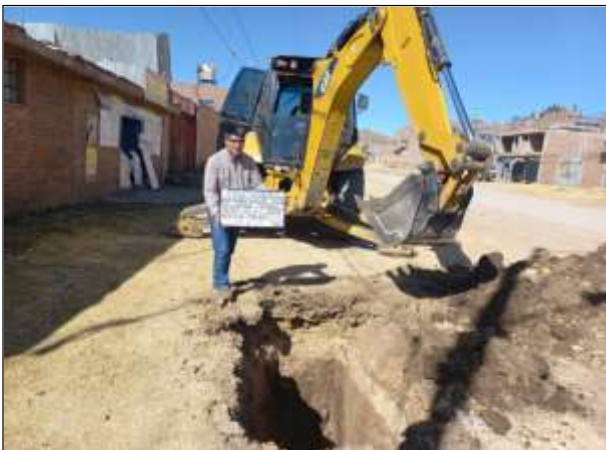
Figura N° 9. Calicata #3 – Av. Industrial margen derecho.
