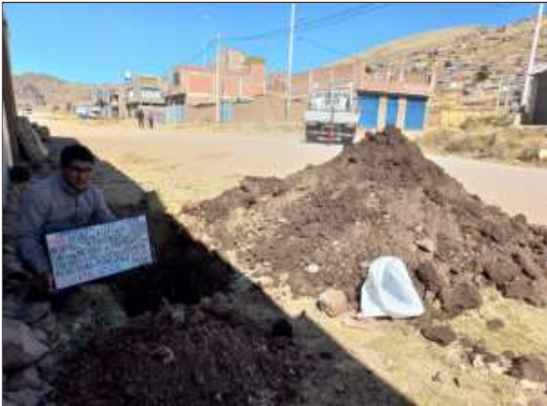
Figura N° 7. Calicata #1 – Av. Industrial margen derecho.
