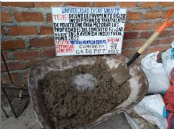
Figura N° 39. Preparación del concreto con 0.5% de PET.
