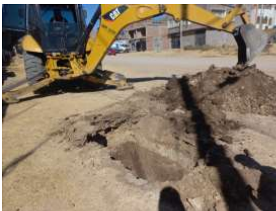
Figura 8. Excavación de calicata.
