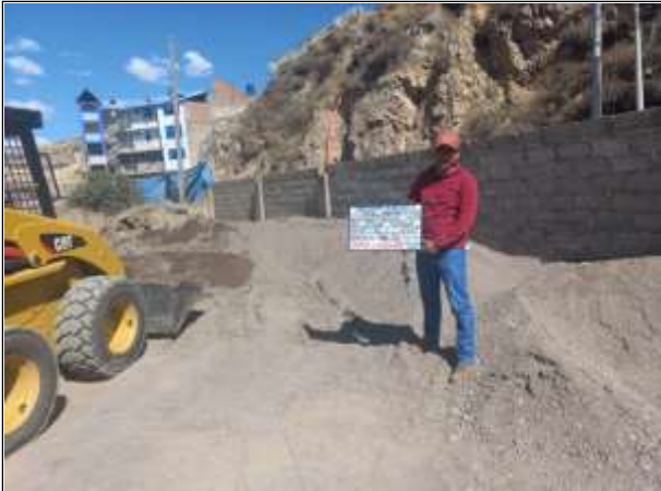
Figura N° 31. Cantera de agregado fino y grueso.
