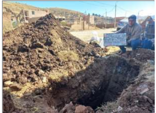
Figura N° 8. Calicata #2 – Av. Industrial margen izquierdo.
