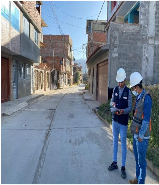
Recolección de fallas Progresiva km 00+14
