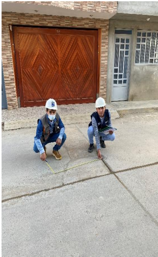
Grietas en esquinas Progresiva km 00+025
