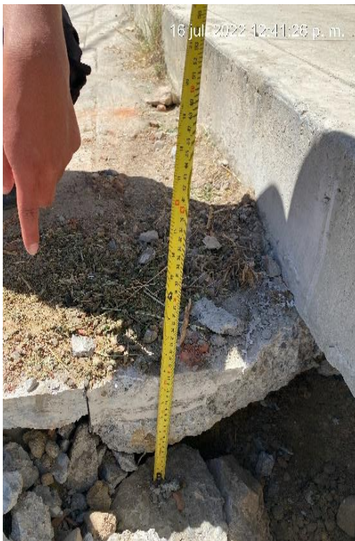
20 cm espesor del pavimento rígido del Jr. horacio Zevallos
