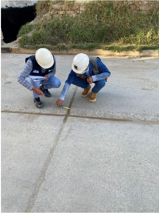
Junta de dilatación Progresiva km 00+042
