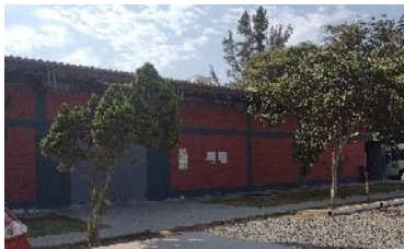
3.- Edificio de ingeniería
