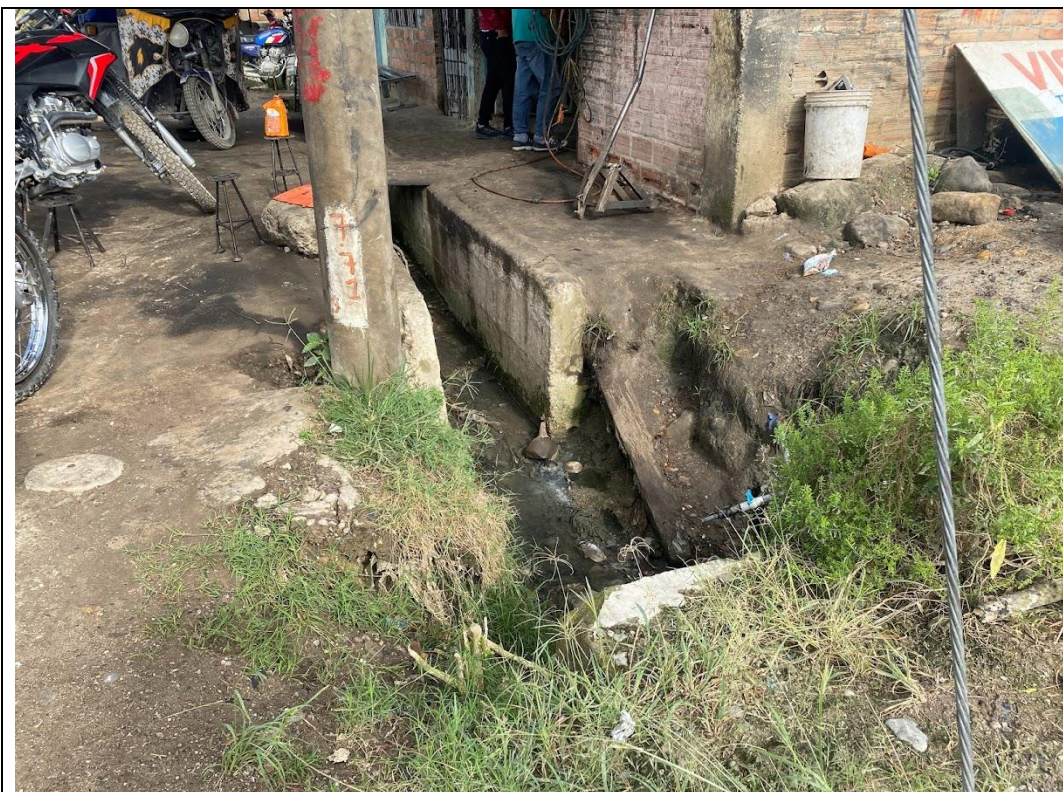
Foto N° 07: condiciones del al redor del canal Galindona (vertido de aceites y grasas)
