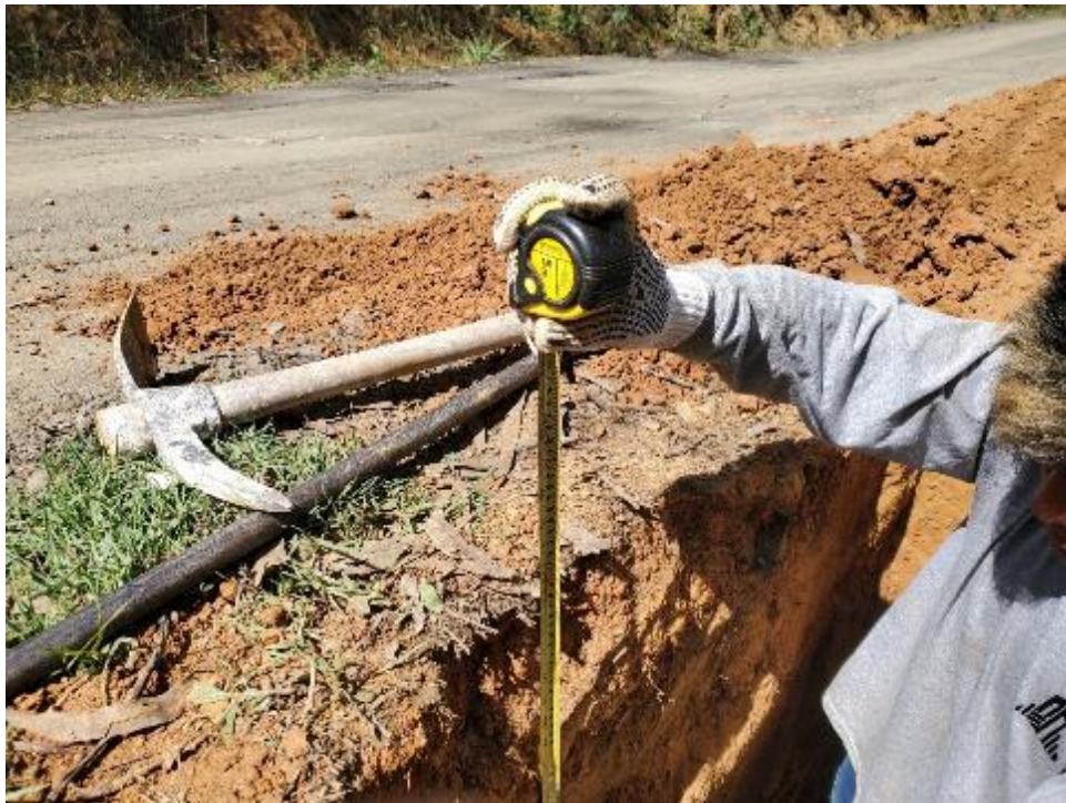
Figura 10. Toma de Medidas de 1.50m en la calicata n°05 Fuente: Elaboración propia / Toma propia
