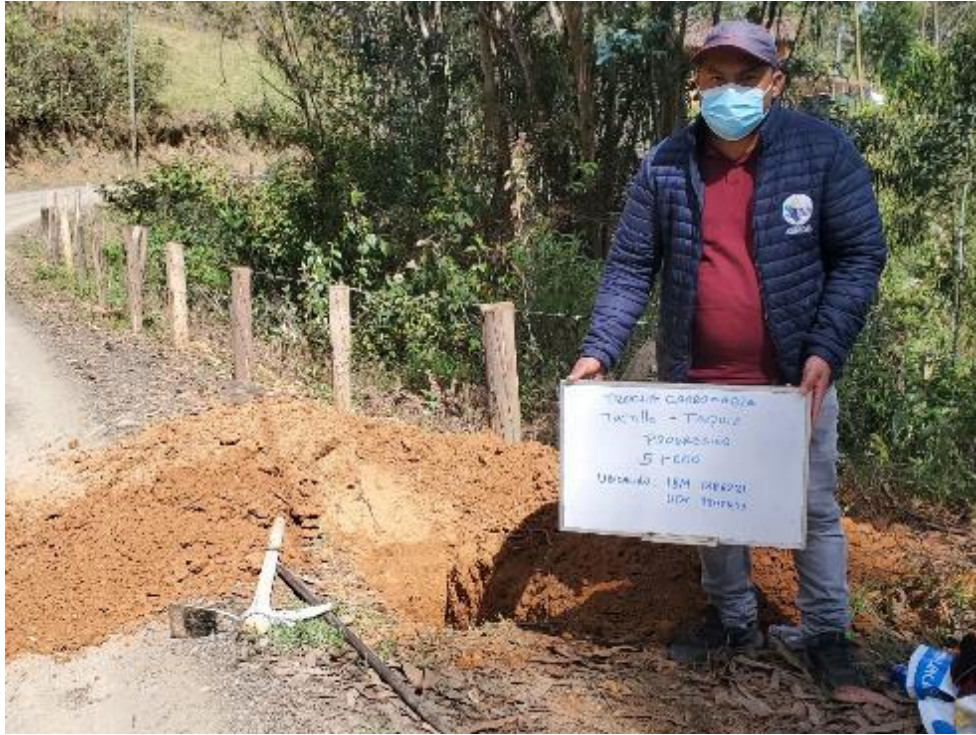
Figura 9. Realización de calicatas (Calicata n° 05) Fuente: Elaboración propia / Toma propia
