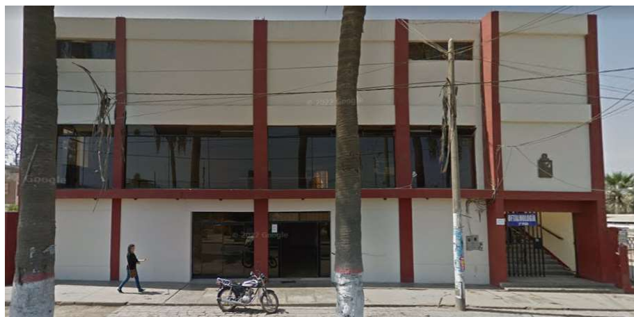
Figura 17. Vista exterior de Centro cultural de Chincha
