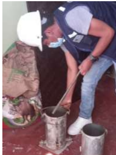
Figura 28. Preparando los moldes para realizar el vaciado.
