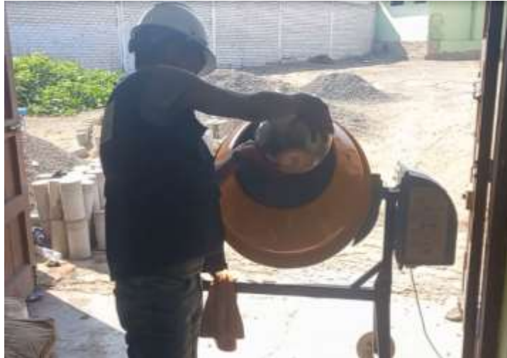
Figura 27. Realizando la mezcla de concreto f'c = 210 \text{ kg/cm}^2 .
