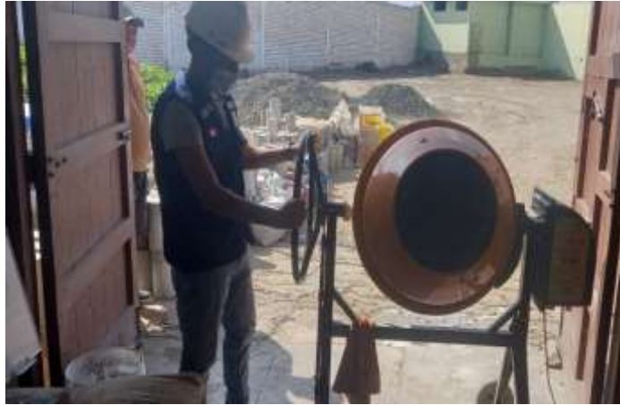
Figura 36. Realizando la mezcla de concreto f'c = 210 \text{ kg/cm}^2 .
