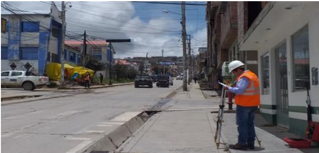
Levantamiento topográfico en el lugar estudiado para un replanteo
