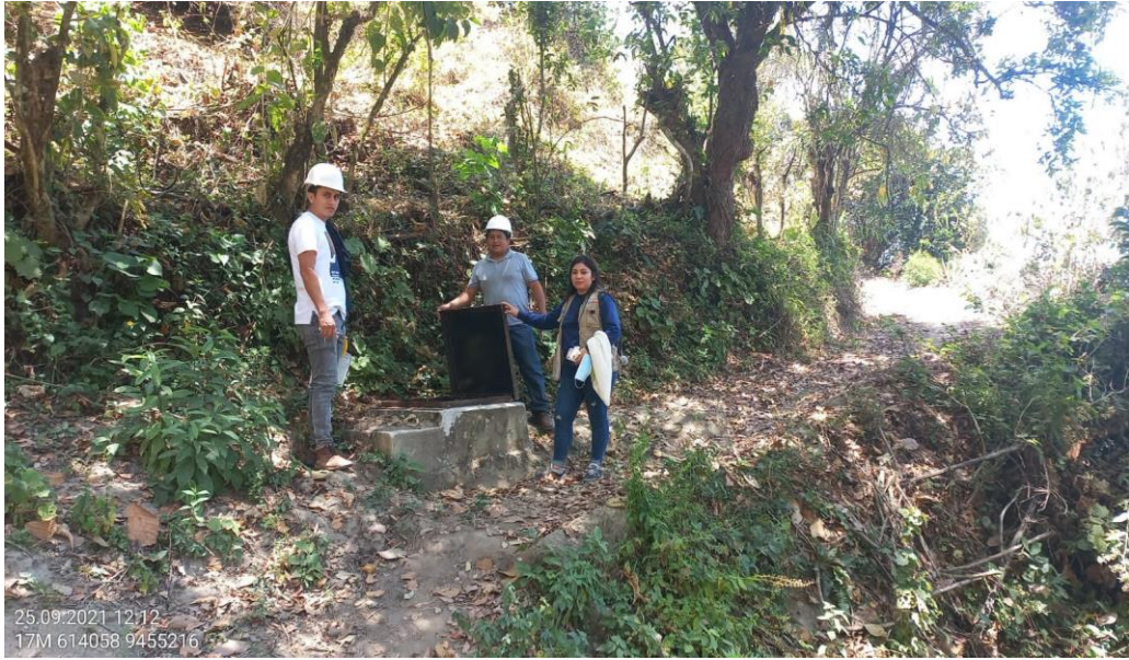
Foto 10. Cámara rompe presión
