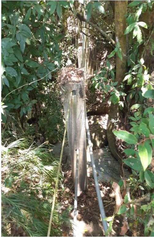
Foto 12 y 13. Mal Estado de los pases aéreos
