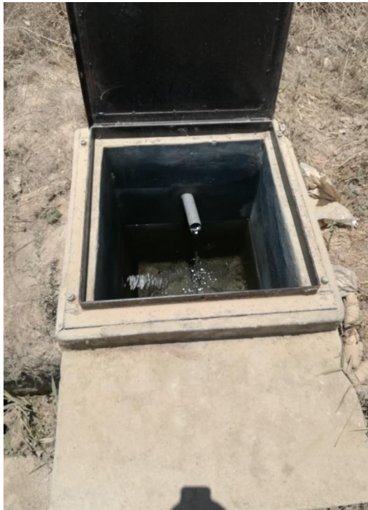
Foto 08 y 09. Estado de la cámara rompe presión
