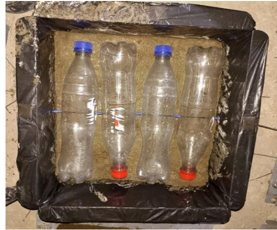
Figura 21. Colocación de botellas en el molde
