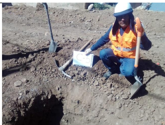
Fotografía 5. Excavación Calicata C-5
