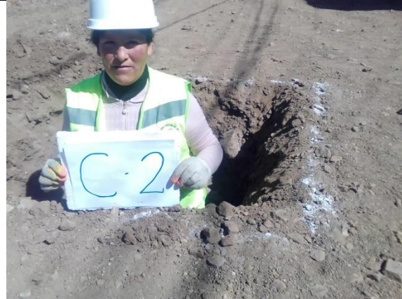
Fotografía 2. Excavación Calicata C-2
