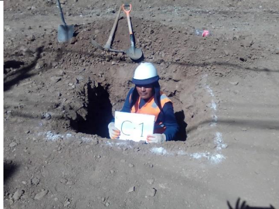
Fotografía 1. Excavación Calicata C-1
