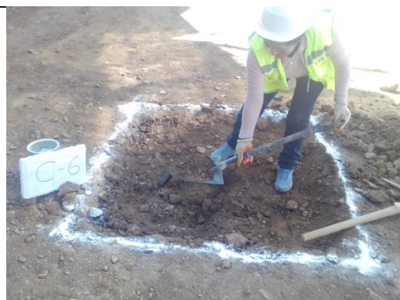
Fotografía 6. Excavación Calicata C-6
