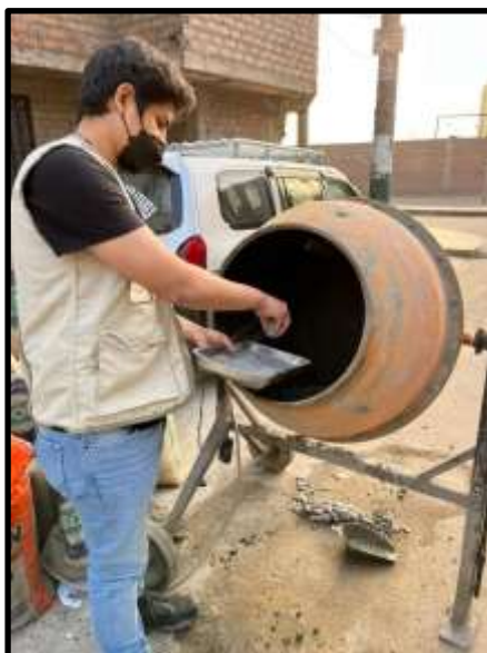
Figura 11. Elaboración de concreto con cenizas
