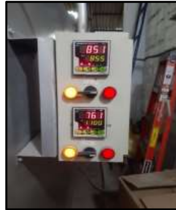
Foto 4. Grado de temperatura para la cremación de huesos de pollo. Fuente: Elaboración propia.
