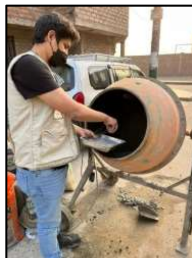
Foto 18. Agregando las cenizas a la mezcla Fuente: Elaboración propia.
