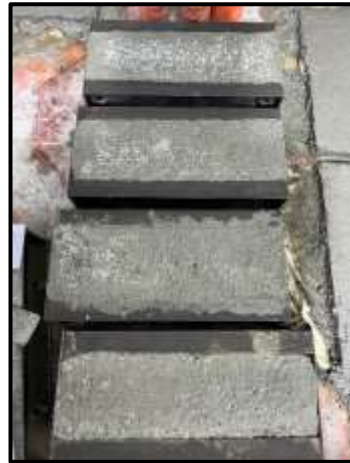
Foto 20. Llenado de vigas Fuente: Elaboración propia.
