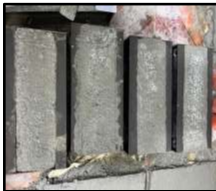
Figura 15. Llenado de vigas
