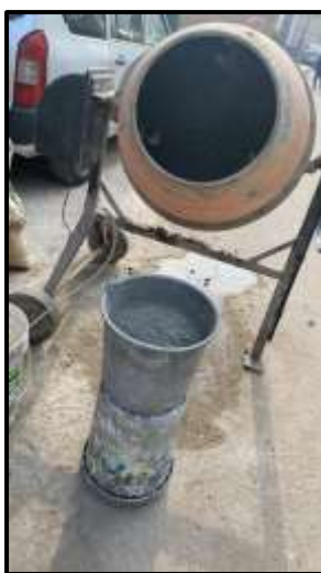
Foto 17. Elaboración del concreto Fuente: Elaboración propia.
