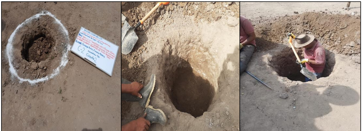
Figura 29 Realización de la segunda calicata
