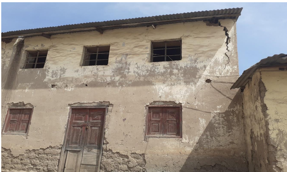
Figura 19 Cubierta de la vivienda 4
