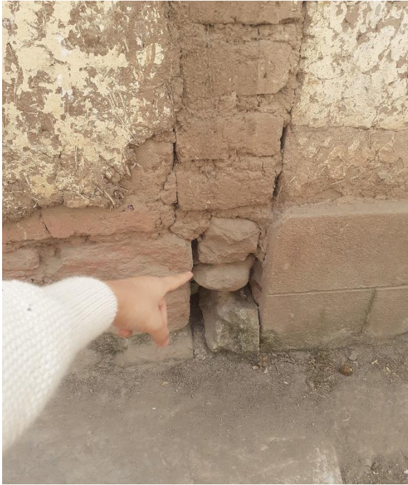
Junta sísmica vivienda 3
