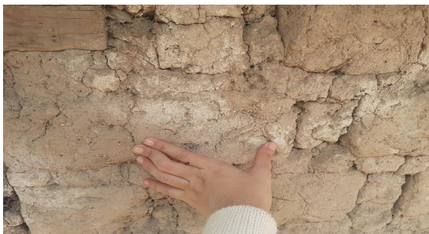
Figura 17 Muros de bloque de adobe en vivienda 5
