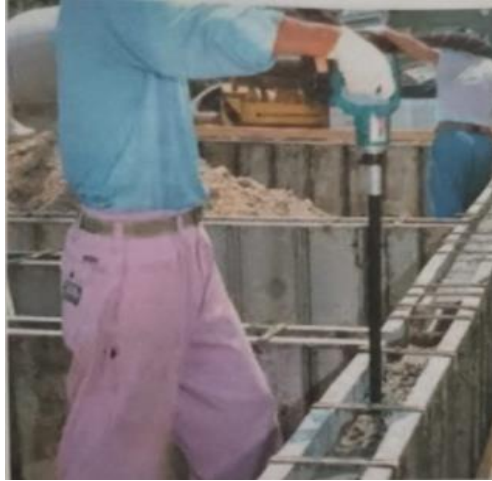
Fig.2 Vibrado de concreto (Jiménez, 2017)
