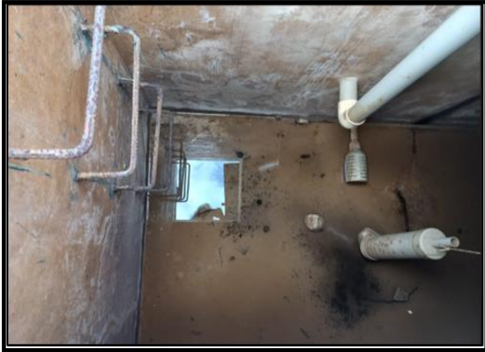
Vista Interior del reservorio, donde se aprecia el estado superficial de la estructura: Malo y estado de Funcionamiento: Malo, la presente estructura se ubica en la Progresiva 0+880.33 km
