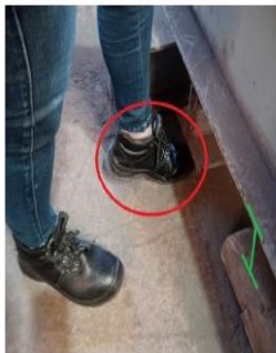
Punto de golpe/atrapamiento entre la viga H y el piso nivel cero
