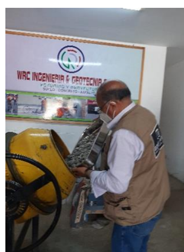
6. Preparación de mezcla
