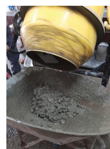
7. Mezcla del concreto
