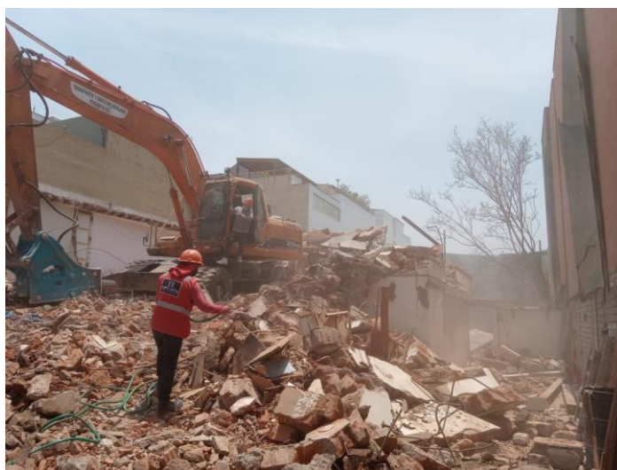
Figura 2. Vivienda en demolición en Surco
