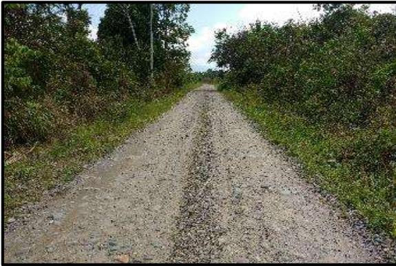
**Foto 33.** Tramo 2+500 al 2+750, Topografía Plano, con un ancho de superficie promedio de 4.00 m. presenta baches y encalaminado.
