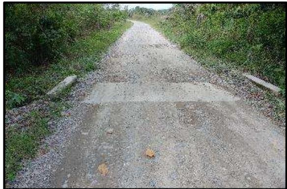
**Foto 34.** Alcantarilla de Concreto ubicado en la Prog. 2+844 en buen estado de transitabilidad, presenta una buena condición estructural y se encuentra limpio.
