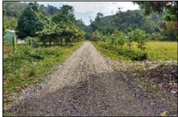
**Foto 20.** Tramo 0+750 al +1000, Topografía Plano, con un ancho de superficie promedio de 4.00 m. presenta erosión y encalaminado.
