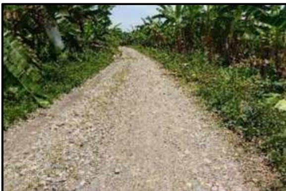
**Foto 85.** Tramo 7+750 al 8+000, Topografía Plano, con un ancho de superficie promedio de 4.00 m. presenta baches y encalaminado.
