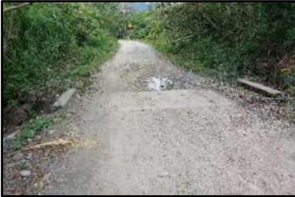
**Foto 37.** Alcantarilla de Concreto ubicado en la Prog. 3+225 en buen estado de transitabilidad, presenta una buena condición estructural y se encuentra parcialmente obstruida.
