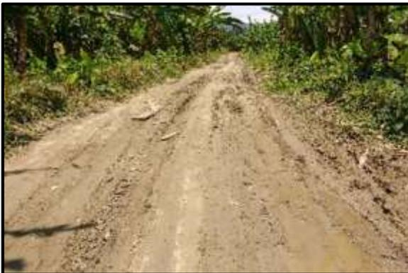
**Foto 95.** Tramo 9+080 al 9+250, Topografía Plano, con un ancho de superficie promedio de 4.00 m. Presenta lodazal.
