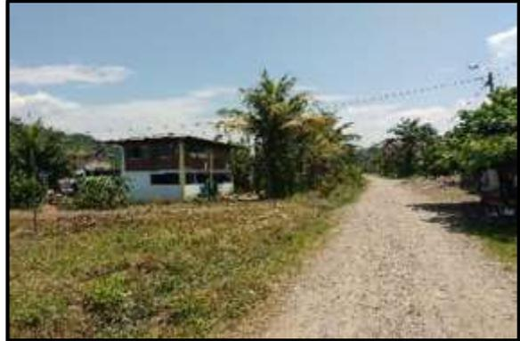
**Foto 110.** C.P. Merced de Locro; Tramo 11+500 al 11+760, Topografía Plano, con un ancho de superficie promedio de 4.00 m. presenta baches y encalaminado.
