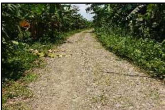
**Foto 89.** Tramo 8+250 al 8+500, Topografía Plano, con un ancho de superficie promedio de 4.00 m. presenta baches y encalaminado.
