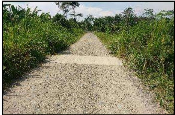
**Foto 76.** Alcantarilla de Concreto ubicado en la Prog. 6+972 en buen estado de transitabilidad, presenta una buena condición estructural y parcialmente obstruida.
