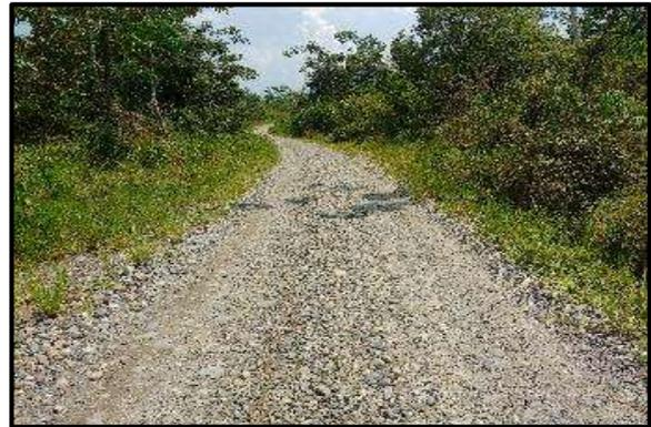
**Foto 52.** Tramo 3+500 al 3+750, Topografía Plano, con un ancho de superficie promedio de 4.00 m. presenta baches y encalaminado.
