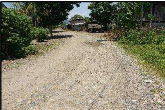
**Foto 75.** Tramo 3+500 al 3+750, Topografía Plano, con un ancho de superficie promedio de 4.00 m. presenta baches y enlaminado.
