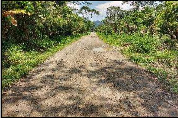
**Foto 109.** Tramo 11+250 al 11+500, Topografía Ondulado, con un ancho de superficie promedio de 4.00m. presenta baches y encalaminado.
