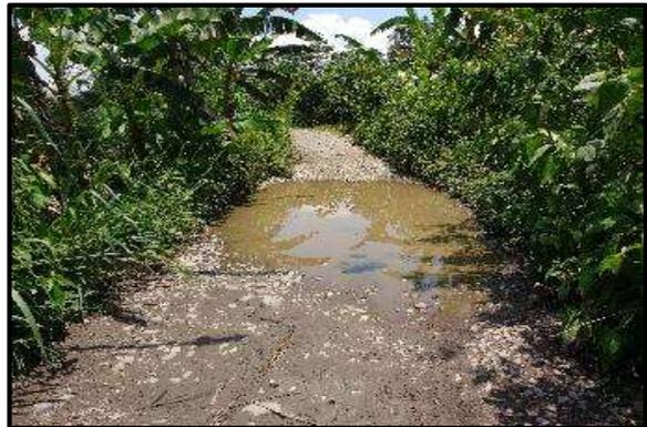
**Foto 106.** Tramo 10+750 al 11+000, Topografía Plano, con un ancho de superficie promedio de 4.00 m. presenta baches.
