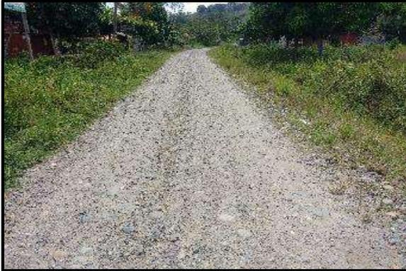
**Foto 43.** Tramo 3+250 al 3+500, Topografía Plano, con un ancho de superficie promedio de 4.00 m. presenta baches y encalaminado.
