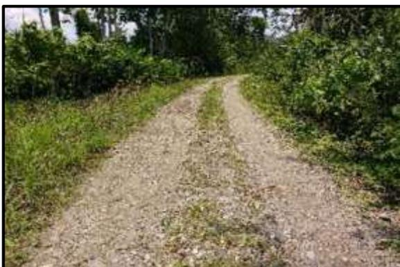
**Foto 99.** Tramo 9+750 al 10+00, Topografía Plano, con un ancho de superficie promedio de 4.00 m. presenta baches y encalaminado.
