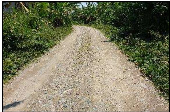
**Foto 84.** Tramo 7+500 al 7+750, Topografía Plano, con un ancho de superficie promedio de 4.00 m. presenta baches y encalaminado.
