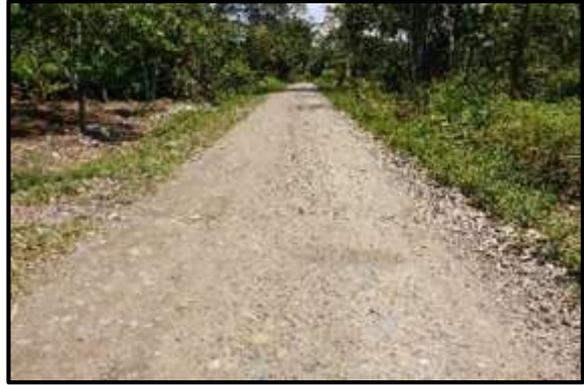
**Foto 62.** Tramo 5+000 al 5+250, Topografía Plano, con un ancho de superficie promedio de 4.00 m. presenta baches y encalaminado.
