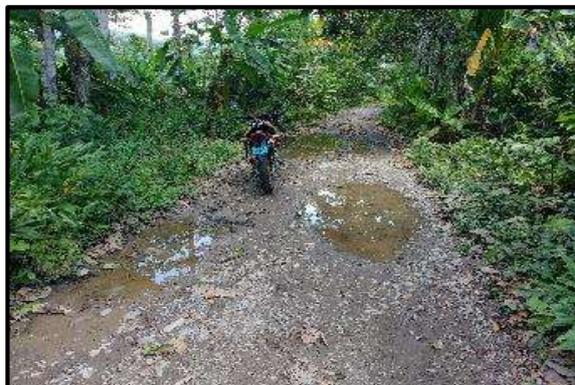
**Foto 100.** Tramo 10+000 al 10+250, Topografía Plano, con un ancho de superficie promedio de 4.00 m. presenta baches.
