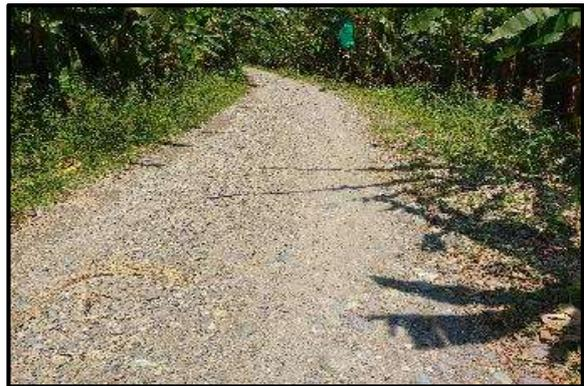
**Foto 92.** Tramo 8+500 al 8+750, Topografía Plano, con un ancho de superficie promedio de 4.00 m. presenta baches.
