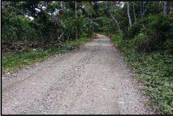
**Foto 49.** Tramo 3+750 al 4+000, Topografía Plano, con un ancho de superficie promedio de 4.00 m. presenta baches y encalaminado.
