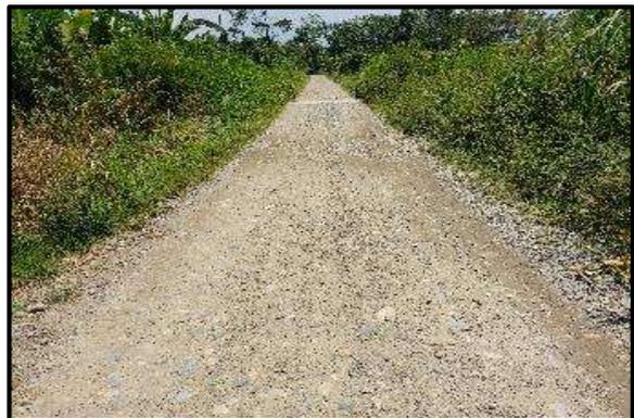
**Foto 72.** Tramo 6+250 al 6+500, Topografía Plano, con un ancho de superficie promedio de 4.00 m. presenta baches y erosión.
