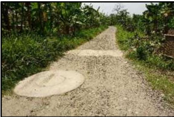
**Foto 81.** Alcantarilla de Concreto ubicado en la Prog. 7+350 en buen estado de transitabilidad, presenta una buena condición estructural y parcialmente obstruida.
