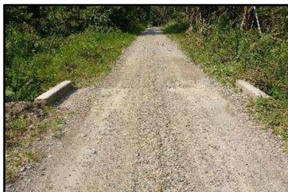
**Foto 56.** Alcantarilla de Concreto ubicado en la Prog. 4+995 en buen estado de transitabilidad, presenta una buena condición estructural y se encuentra parcialmente obstruida.
