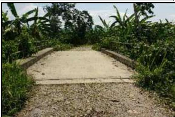
**Foto 87.** Prog. 8+462, Pontón definitivo de concreto reforzado en buena condición estructural y parcialmente obstruida; long: 7.70m y ancho: 3.90m.
