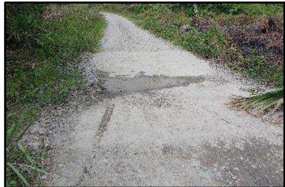
**Foto 46.** Prog. 3+767, Baden de concreto en excelente condición funcional y parcialmente obstruida.
