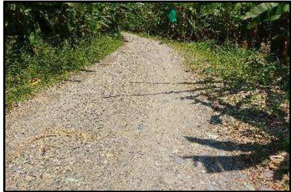
**Foto 80.** Tramo 7+000 al 7+250, Topografía Plano, con un ancho de superficie promedio de 4.00 m. presenta erosión.
