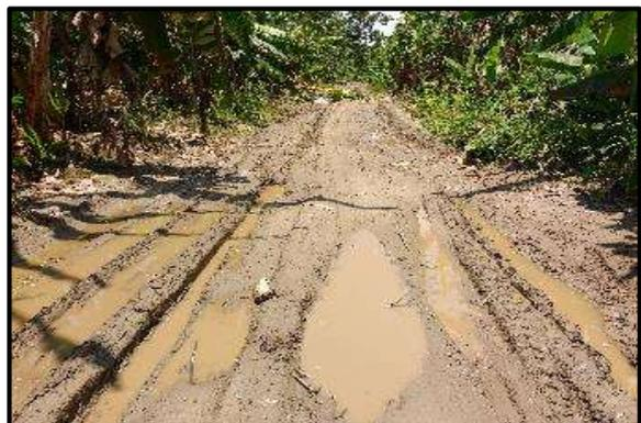
**Foto 96.** Tramo 9+250 al 9+500, Topografía Plano, con un ancho de superficie promedio de 4.00 m. presenta baches y lodazal.
