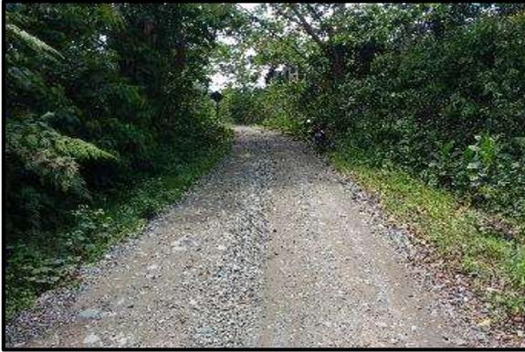
**Foto 31.** Tramo 2+250 al 2+500, Topografía Plano, con un ancho de superficie promedio de 4.00 m. presenta baches y encalaminado.
