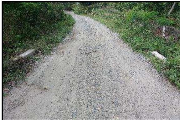
**Foto 26.** Alcantarilla de Concreto ubicado en la Prog. 2+000, Tramo 1+750 al 2+000, Topografía Ondulado, con un ancho de superficie promedio de 4.90 m. presenta baches.
