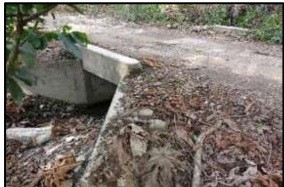
**Foto 48.** Vista lateral de la Alcantarilla ubicado en la Prog. 3+970.
