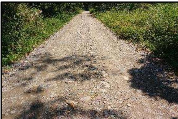
**Foto 65.** Tramo 5+500 al 5+750, Topografía Plano, con un ancho de superficie promedio de 4.00 m. presenta baches y encalaminado.
