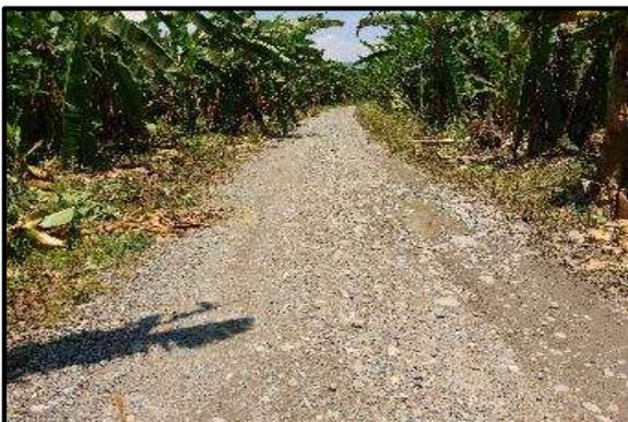
**Foto 83.** Tramo 7+250 al 7+500, Topografía Plano, con un ancho de superficie promedio de 4.00 m. presenta baches y erosión.
