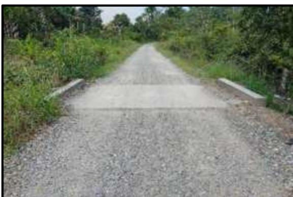
**Foto 29.** Alcantarilla de Concreto ubicado en la Prog. 2+453 en buen estado de transitabilidad, presenta una buena condición estructural y se encuentra limpio.
