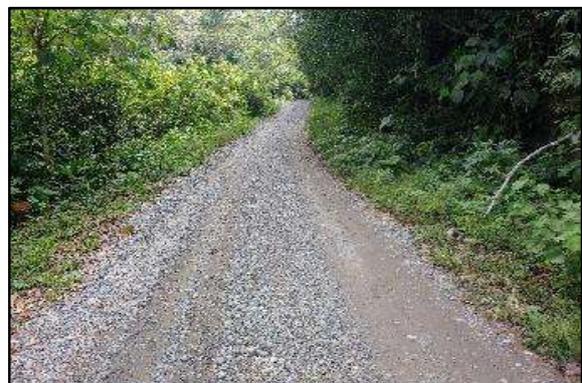
**Foto 22.** Tramo 1+000 al 1+250, Topografía Plano, con un ancho de superficie promedio de 4.00 m. presenta erosión y encalaminado.
