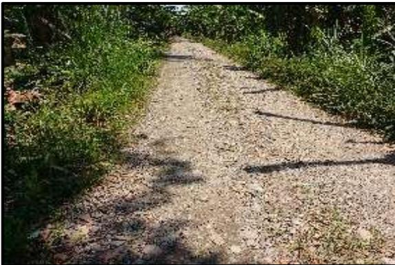
**Foto 93.** Tramo 8+750 al 9+000, Topografía Plano, con un ancho de superficie promedio de 4.00 m. presenta baches y encalaminado.
