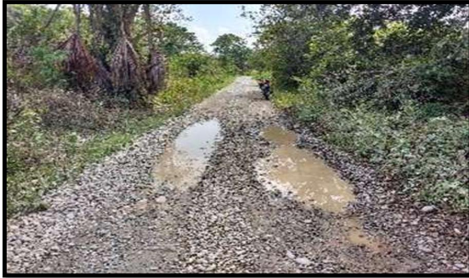
**Foto 28.** Tramo 2+000 al 2+250, Topografía Plano, con un ancho de superficie promedio de 3.80 m. presenta baches y encalaminado.
