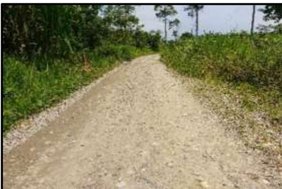
**Foto 71.** Tramo 6+000 al 6+250, Topografía Plano, con un ancho de superficie promedio de 4.00 m. presenta baches.
