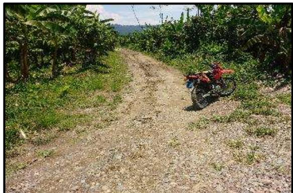
**Foto 94.** Prog. 9+080, Inicio de Lodazal, Topografía Plano, con un ancho de superficie promedio de 4.00 m.
