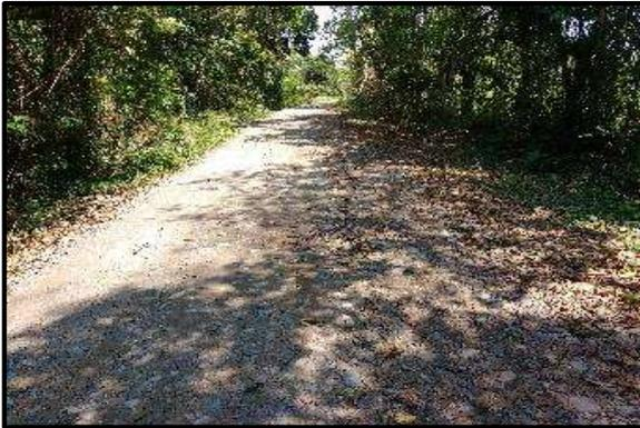
**Foto 63.** Tramo 5+250 al 5+500, Topografía Plano, con un ancho de superficie promedio de 4.00 m. presenta erosión y baches.
