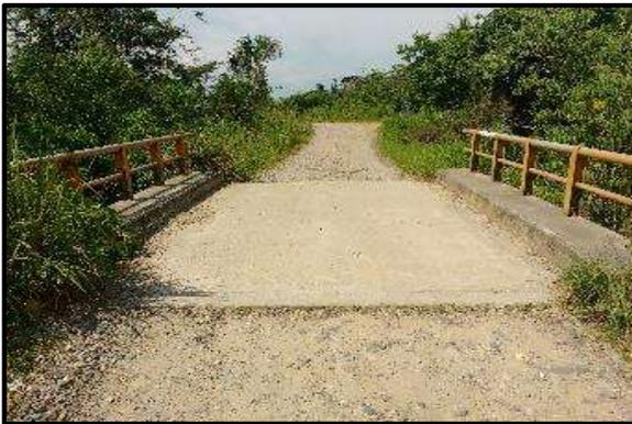
**Foto 69.** Prog. 6+175, Pontón definitivo de concreto reforzado en buena condición estructural y parcialmente obstruida; long: 5.00m y ancho: 3.50m.
