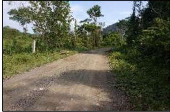
**Foto 16.** Tramo 0+000 al 0+750, Topografía Plano, con un ancho de superficie promedio de 4.00 m. presenta deformación y baches.
