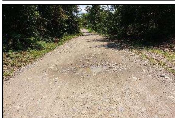
**Foto 58.** Tramo 4+750 al 5+000, Topografía Plano, con un ancho de superficie promedio de 4.00 m. presenta baches.
