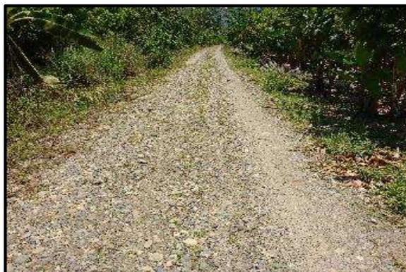
**Foto 98.** Tramo 9+610 al 9+750, Topografía Plano, con un ancho de superficie promedio de 4.00 m. presenta baches y encalaminado.
