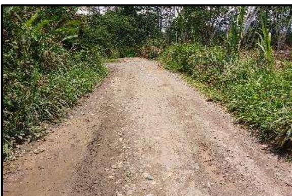
**Foto 107.** Tramo 11+000 al 11+250, Topografía Plano, con un ancho de superficie promedio de 4.00 m. presenta baches y encalaminado.
