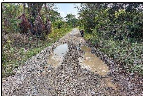
**Foto 28.** Tramo 2+000 al 2+250, Topografía Plano, con un ancho de superficie promedio de 4.00 m. presenta baches y encalaminado.
