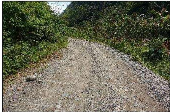
**Foto 24.** Tramo 1+250 al 1+500, Topografía Ondulado, con un ancho de superficie promedio de 3.50 m. presenta erosión y encalaminado.
