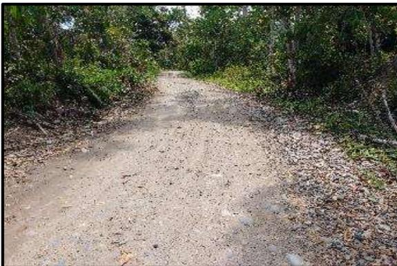
**Foto 39.** Tramo 3+00 al 3+250, Topografía Plano, con un ancho de superficie promedio de 4.00 m. presenta baches.
