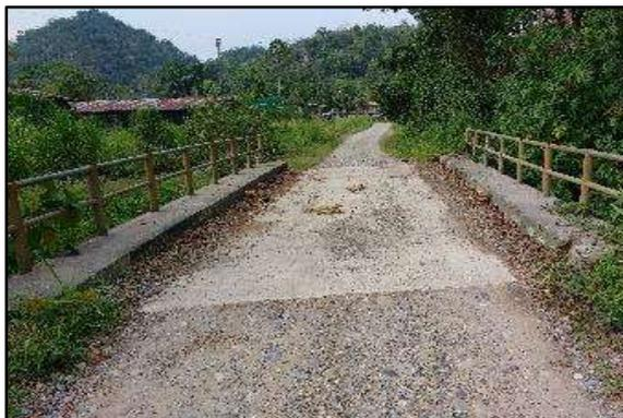
**Foto 17.** Prog. 0+770, Pontón definitivo de concreto reforzado en buena condición estructural; long: 8.10m y ancho: 3.60m.
