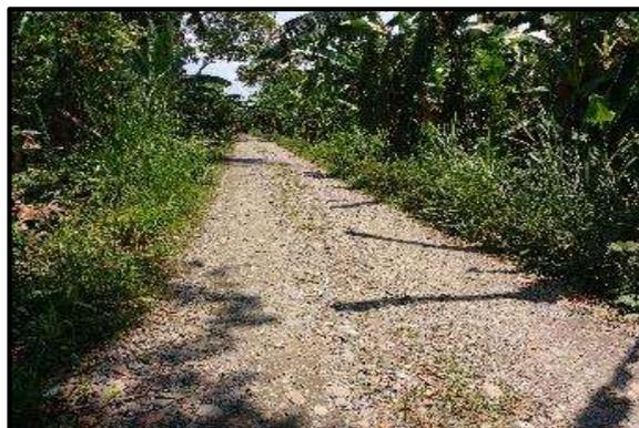
**Foto 86.** Tramo 8+000 al 8+250, Topografía Plano, con un ancho de superficie promedio de 4.00 m. presenta baches.
