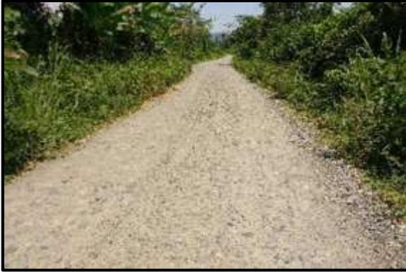
**Foto 67.** Tramo 5+750 al 6+000, Topografía Plano, con un ancho de superficie promedio de 4.00 m. presenta encalaminado.
