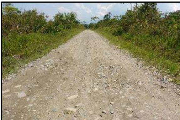
**Foto 53.** Tramo 4+250 al 4+500, Topografía Plano, con un ancho de superficie promedio de 4.00 m. presenta baches.
