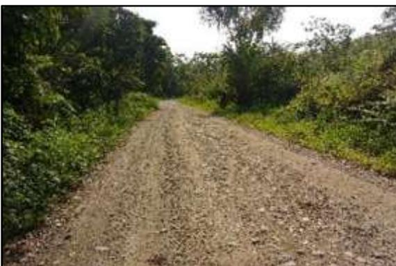
**Foto 05.** Tramo 0+000 al 0+250, Topografía Ondulado, con un ancho de superficie promedio de 4.00 m. presenta encalaminado y baches
