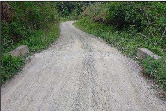
**Foto 03.** Alcantarilla de Concreto ubicado en la Prog. 0+077 en buen estado de transitabilidad, presenta una buena condición estructural y se encuentra parcialmente Obstruida.
