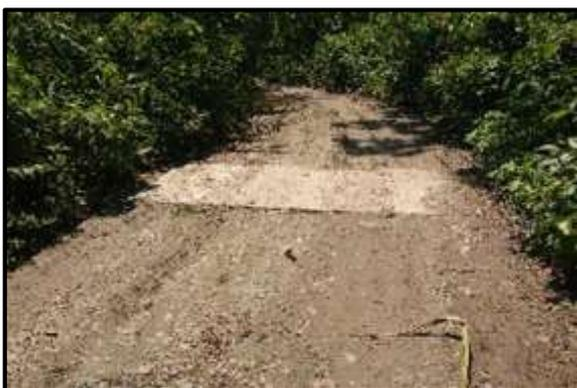
**Foto 101.** Alcantarilla de Concreto ubicado en la Prog. 10+492 en buen estado de transitabilidad, presenta una buena condición estructural y parcialmente obstruida.
