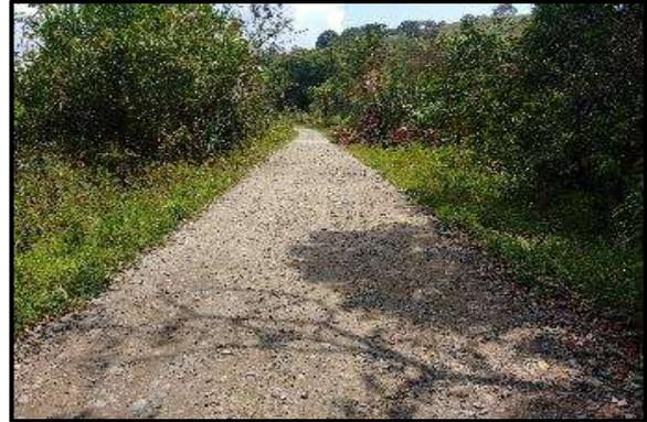
**Foto 44.** Tramo 3+500 al 3+750, Topografía Plano, con un ancho de superficie promedio de 4.00 m. presenta baches y encalaminado.
