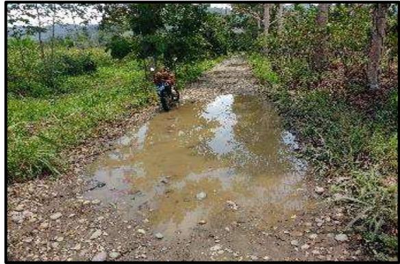
**Foto 104.** Tramo 10+500 al 10+750, Topografía Plano, con un ancho de superficie promedio de 4.00 m. presenta baches.
