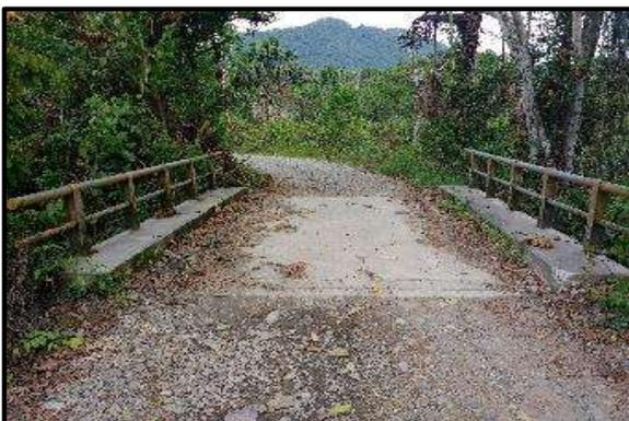
**Foto 41.** Prog. 3+347, pontón definitivo de concreto reforzado en buena condición estructural; Long. 5.00m y ancho: 3.50m.
