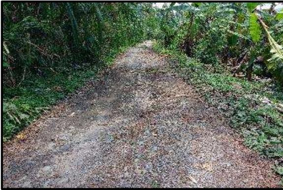
**Foto 103.** Tramo 10+250 al 10+500, Topografía Plano, con un ancho de superficie promedio de 4.00 m. presenta baches y encalaminado.
