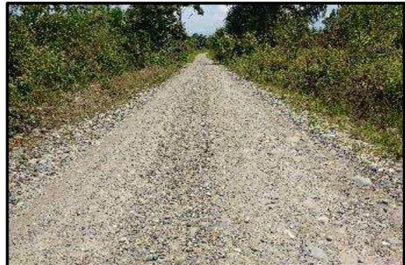
**Foto 54.** Tramo 4+500 al 4+750, Topografía Plano, con un ancho de superficie promedio de 4.00 m. presenta baches y encalaminado.
