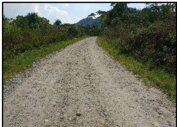
**Foto 36.** Tramo 2+750 al 3+000, Topografía Plano, con un ancho de superficie promedio de 4.00 m. presenta baches y encalaminado.
