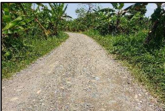
**Foto 77.** Tramo 6+750 al 7+000, Topografía Plano, con un ancho de superficie promedio de 4.00 m. presenta enlaminado.
