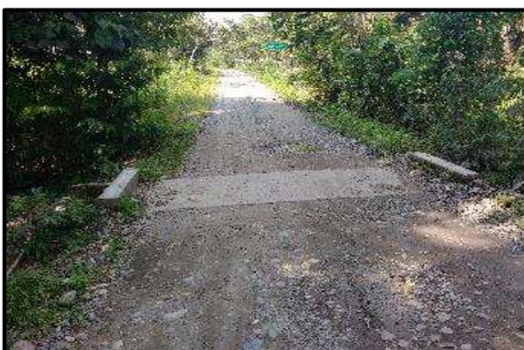
**Foto 59.** Alcantarilla de Concreto ubicado en la Prog. 5+118 en buen estado de transitabilidad, presenta una buena condición estructural y se encuentra limpia.
