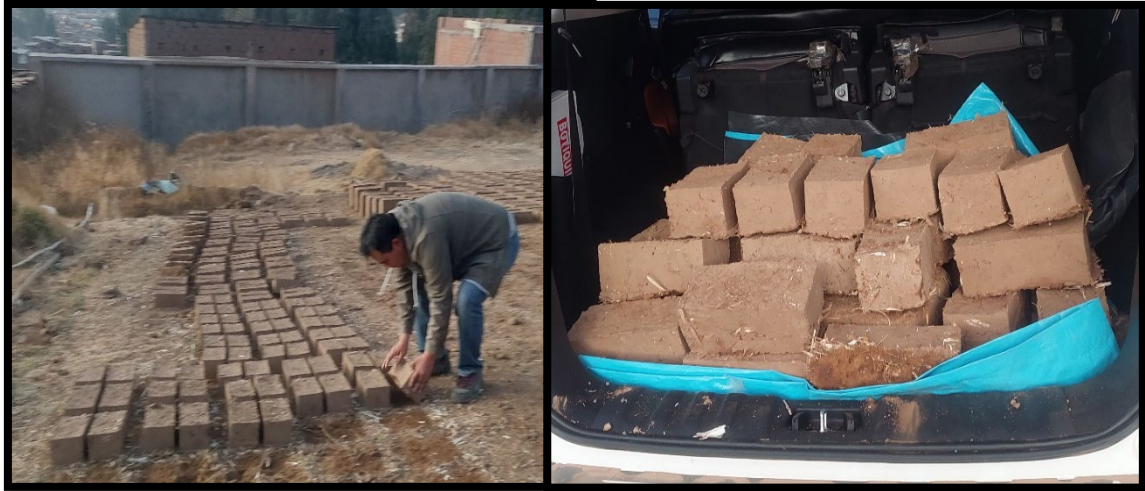
Figura 18: Acopio y transporte de unidades de adobe
