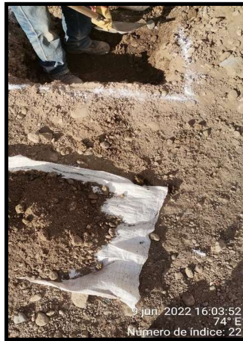
Figura 13. Excavación de C2 – Toma de muestra
