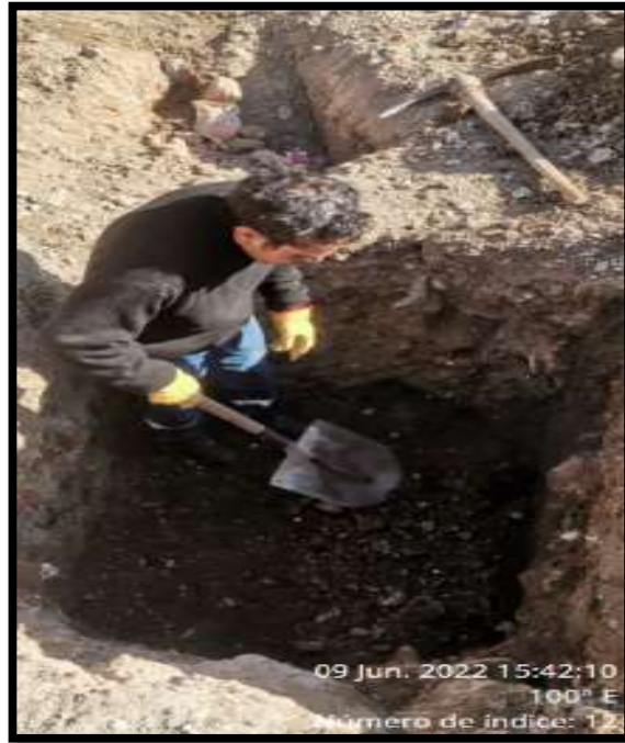
Figura 12. Excavación de C2 de 1.50 m – Toma de muestra
