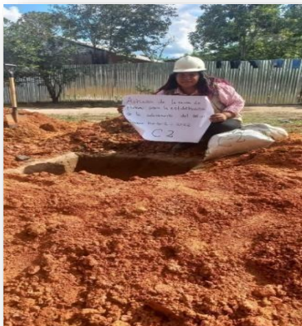
Figura 11. Excavación de calicata con 1.50 m de profundidad en la carretera Curimana -Maronal
