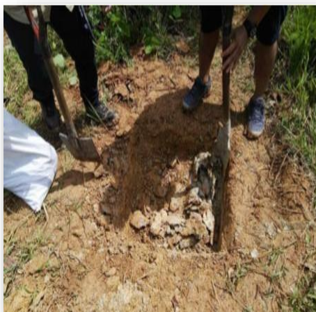
Figura 10. Excavación de calicata en la carretera Curimana -Maronal
