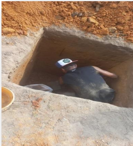
Figura 9. Calicatas ya excavadas en la carretera Curimana-Maronal
