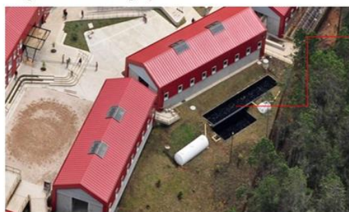
Figura 3: biodigestor para tratamiento de estiércol
