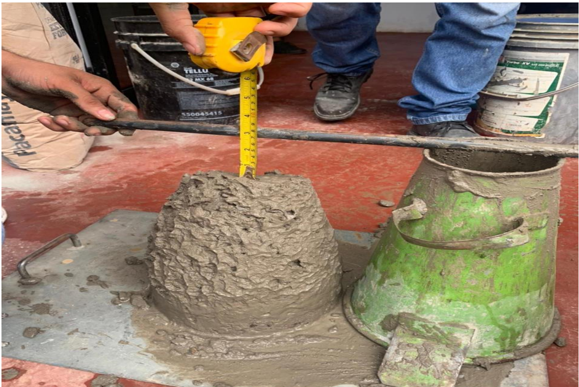
Figura 13. Ensayo del cono de abras – Slump
