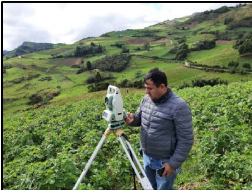
Figura 4: Vista de trabajos en campo de topografía.
