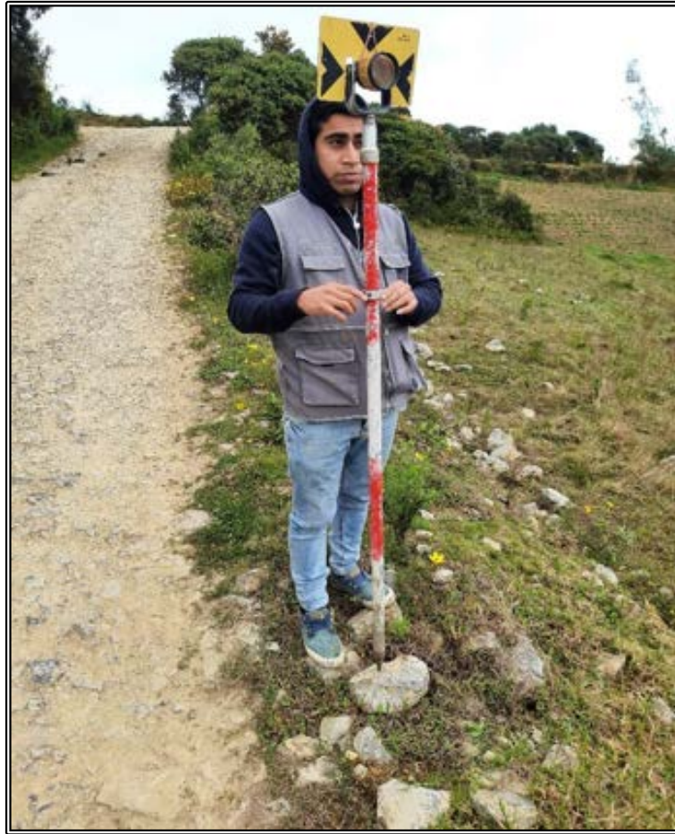
Figura 3: Vista de trabajos en campo de topografía.
