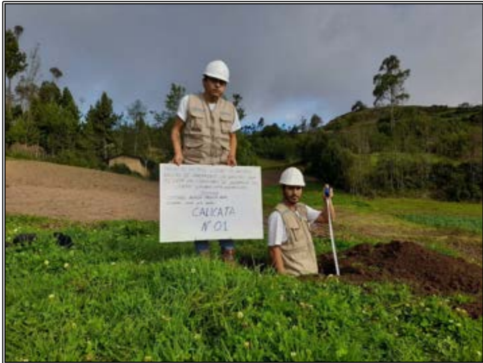
Figura 13: Vista preliminar de la calicata N° 01
