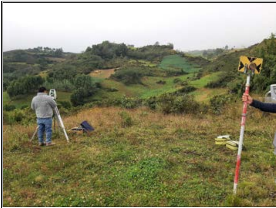
Figura 1: Vista de trabajos en campo de topografía.
