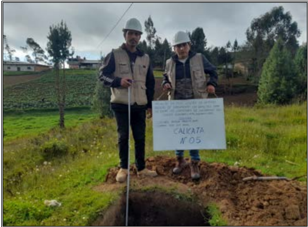
Figura 21: Vista preliminar de calicata N° 05
