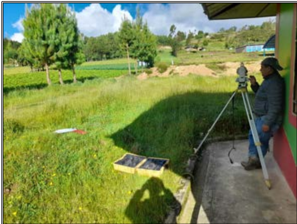
Figura 10: Vista de trabajos en campo de topografía.
