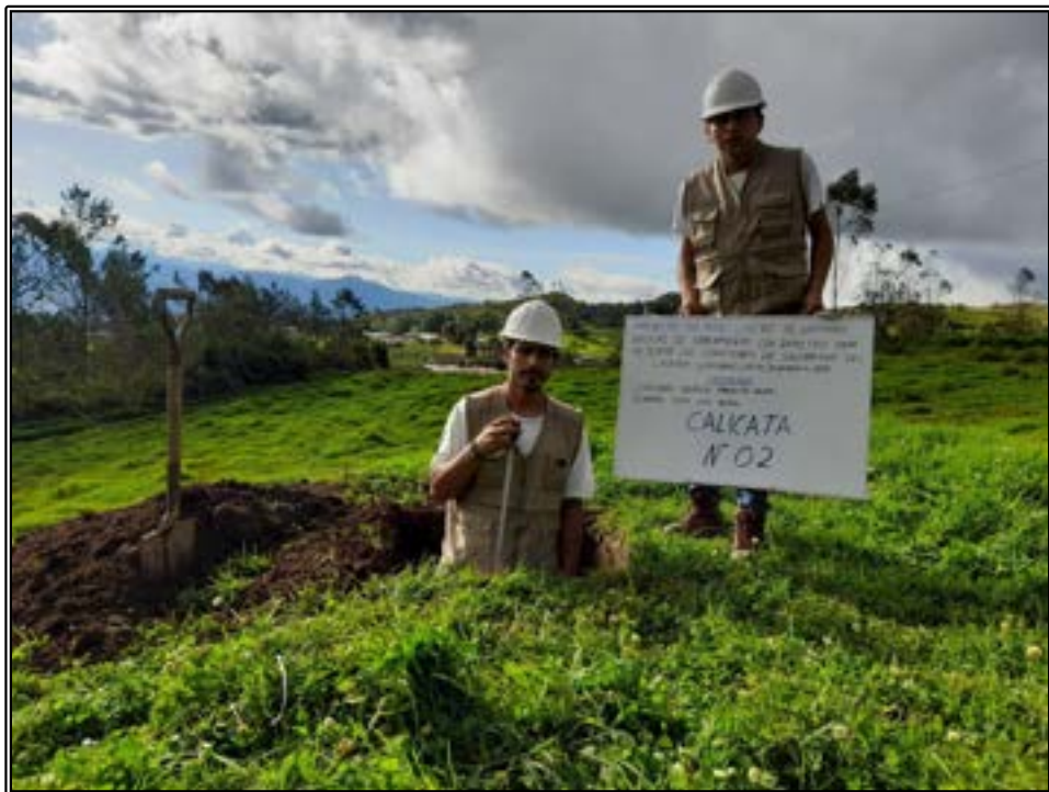
Figura 16: Vista de medidas correspondientes de la calicata N° 02
