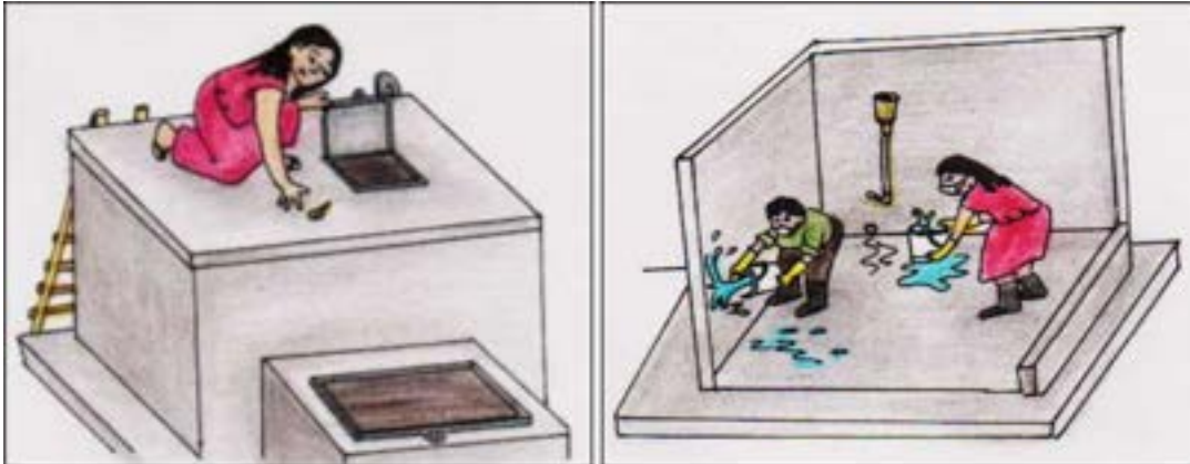
Figura 7. Limpieza interna de reservorio
