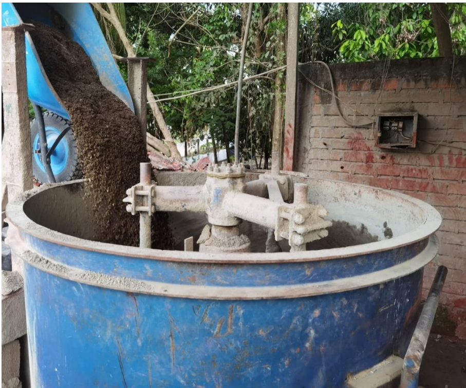
Foto N° 18: Se mezcló el agregado con el cemento en la mezcladora.
