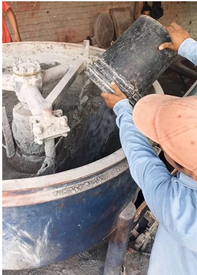
Foto N° 20: Se incorpora la ceniza de cascarilla de arroz a la mezcla.
