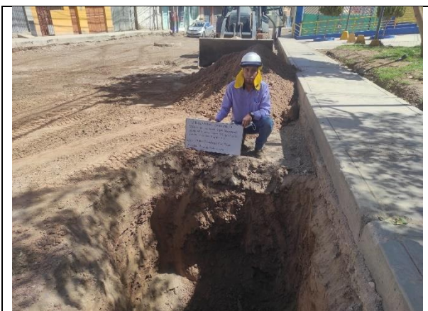
Figura N° 09. Inicio de toma de muestra de calicata en Avenida 28 de Julio.
