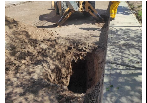
Figura N° 08. Calicata realizada en la Avenida 28 de Julio.
