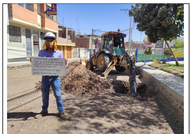
Figura N° 10. Excavación de calicata para el estudio de mecánica de suelos.
