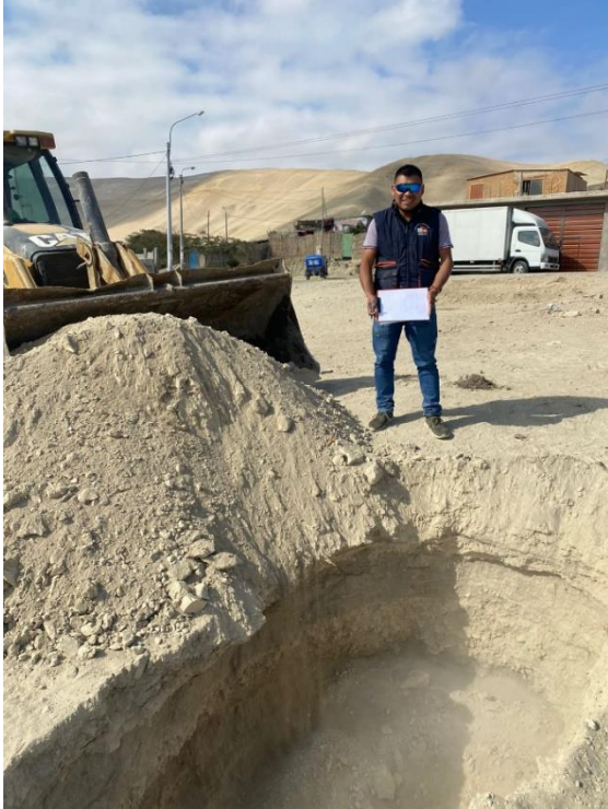
Nota. Excavacion de Calicata N°1.
