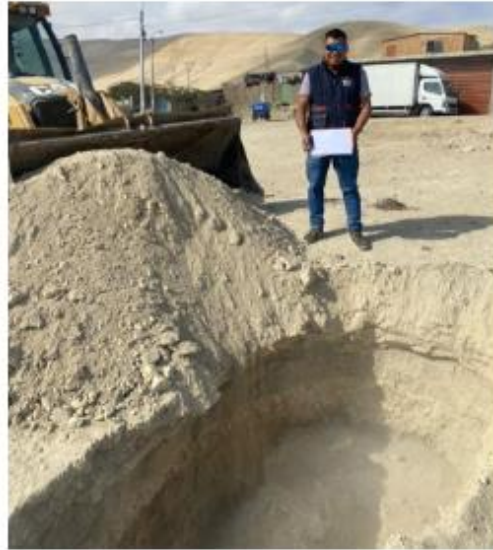
Foto: 1 Panorámico de la Calicata N°1:
