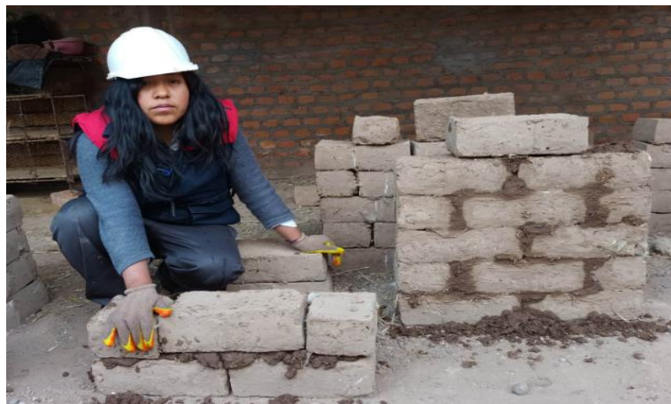
Figura 36. Elaboración de los muros de adobe.
