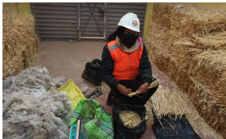
Figura 30.- Corte de la fibra de avena (paca de avena).
