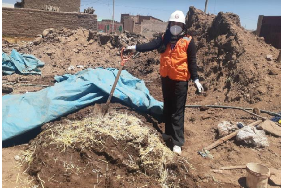
Fotografía 9. Mezcla de la tierra más fibra de avena
