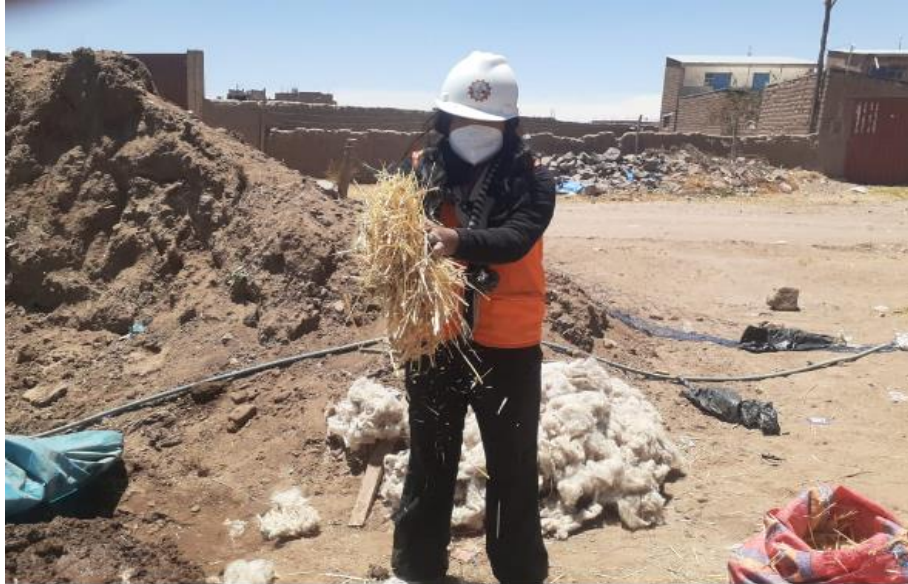
Fotografía 10. Adición de fibras (fibra de alpaca y paca de avena).
