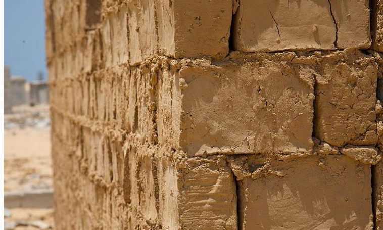
Figura 1. Muros de adobe
