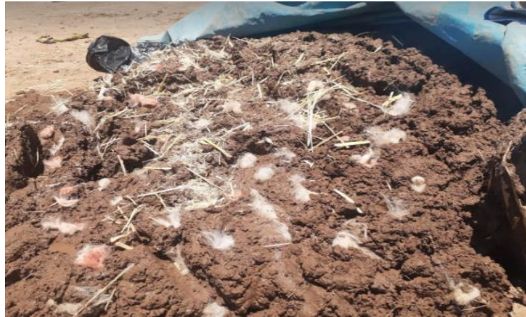
Figura 33. Mezcla de los materiales
