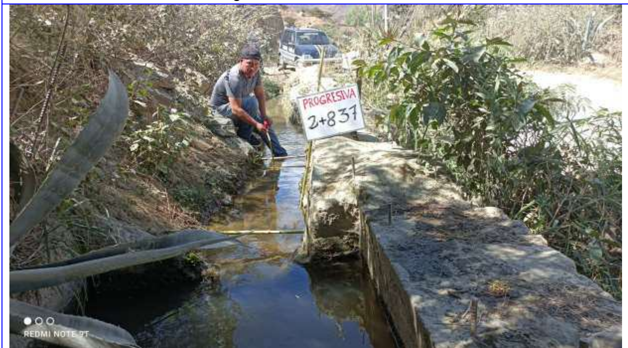
Foto N° 02: En la imagen se observa realizando el aforo del caudal al final del tramo del canal que se ubica en la progresiva 2+837, los aforos se realizaron cada 100 metros.
