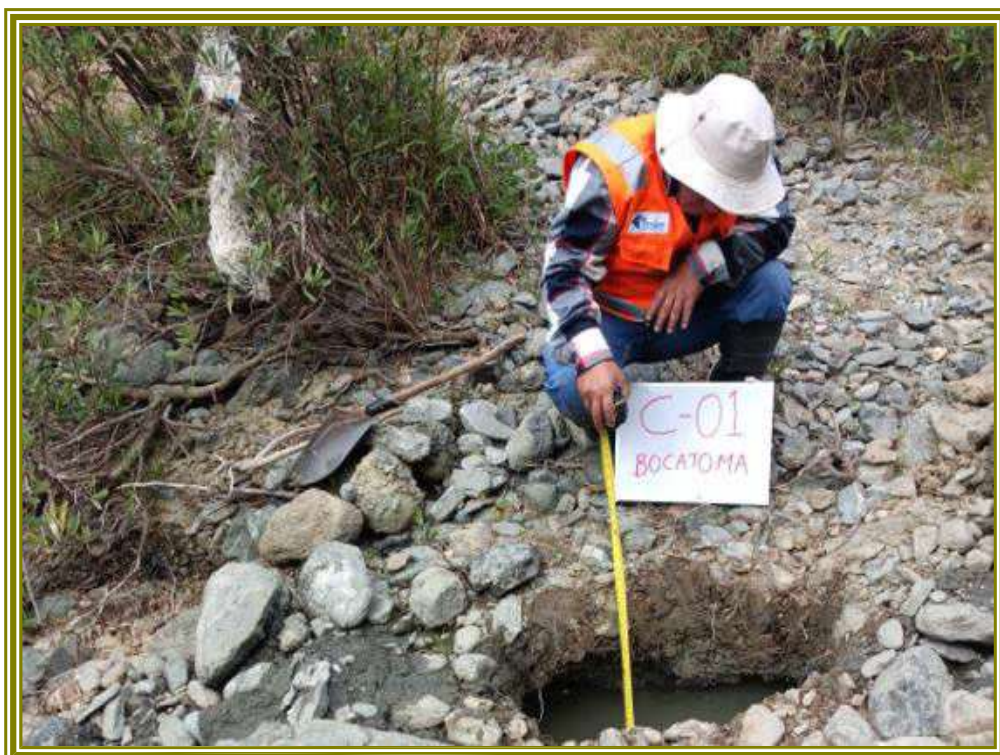
VISTA FOTOGRAFICA DE LA CALICATA N° 01
