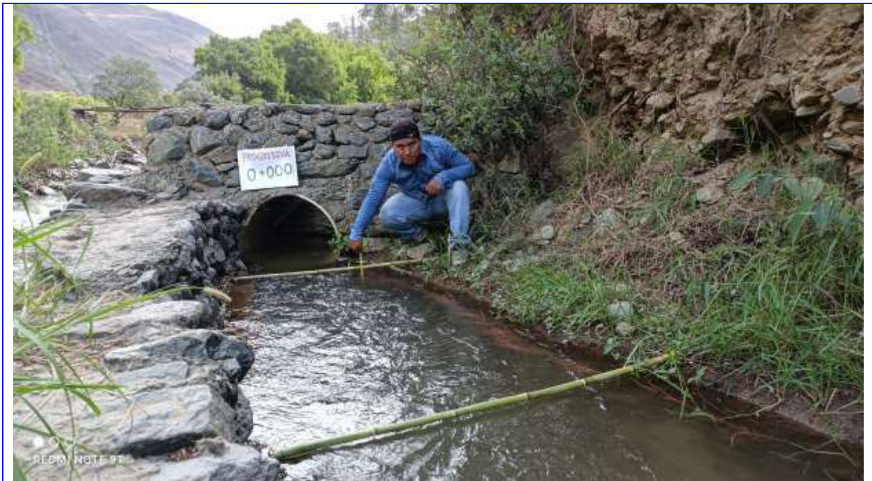
Foto N° 01: En la imagen se aprecia realizando el aforo del caudal de ingreso por el método del flotador en la progresiva 0+000, los datos que se toman se realizan en un tramo de 2 metros, lo cual se registran en la ficha de evaluación.
