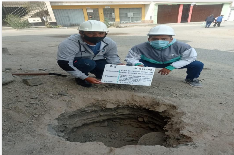
Figura 5. Ejecución de Calicatas
