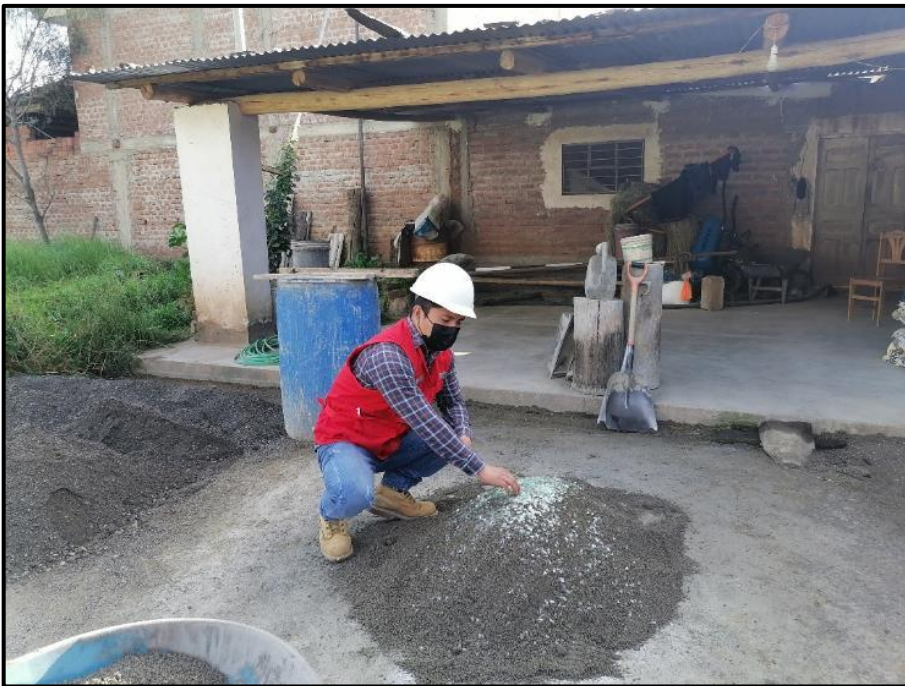
Gráfico 19 Batido de fibras de polietileno tereftalato (PET) con agregados
