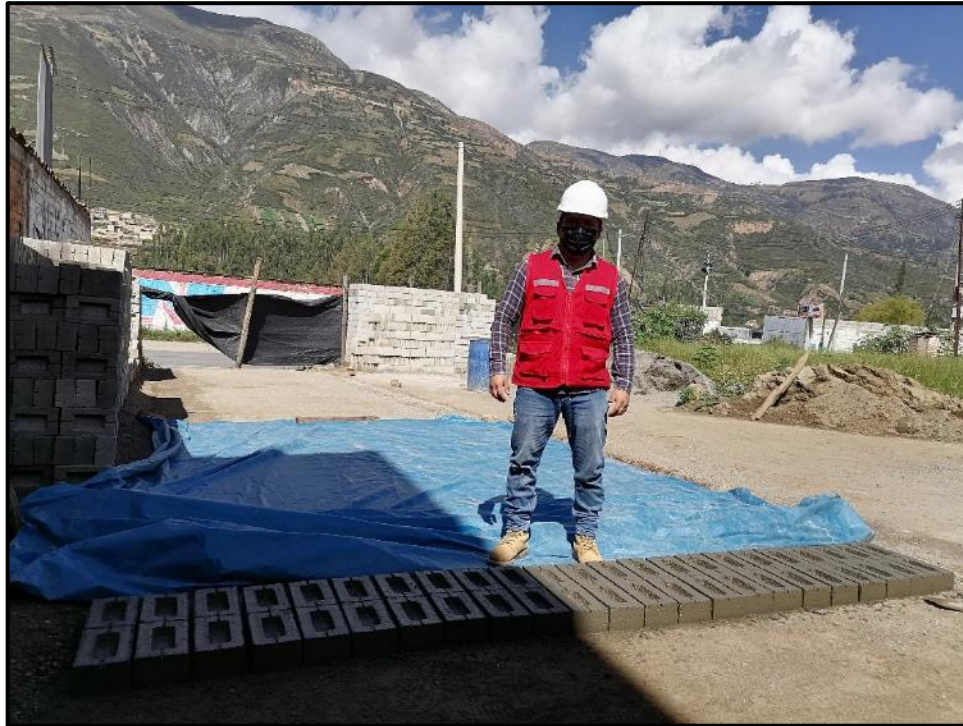
Gráfico 20 Desmolde de ladrillos de concreto
