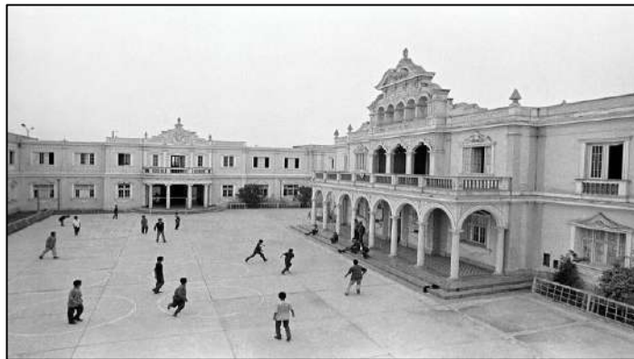
Figura 05. Vista área de recreación.
