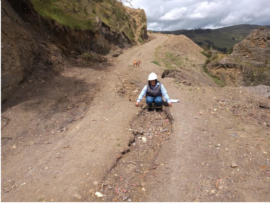
Foto 11. Medición del ancho de la grietas o canales
