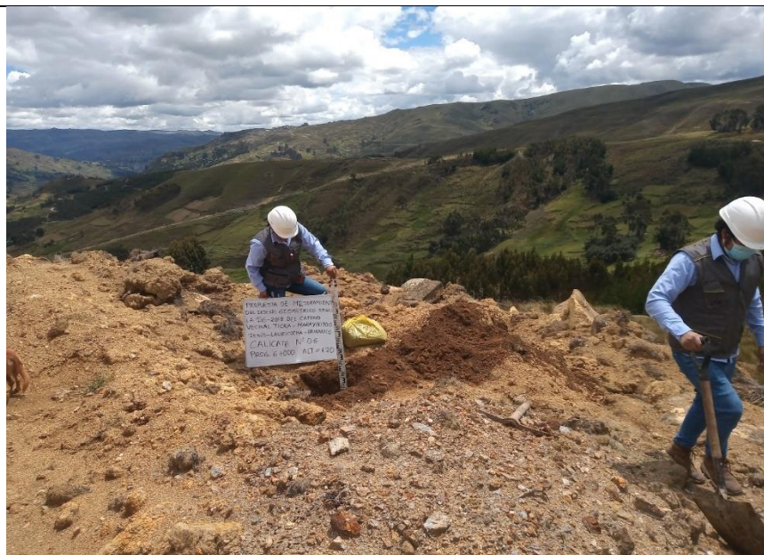
Foto 20. Extracción de las muestras de la calicata
