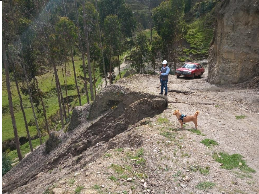
Foto 12. Erosión del talud
