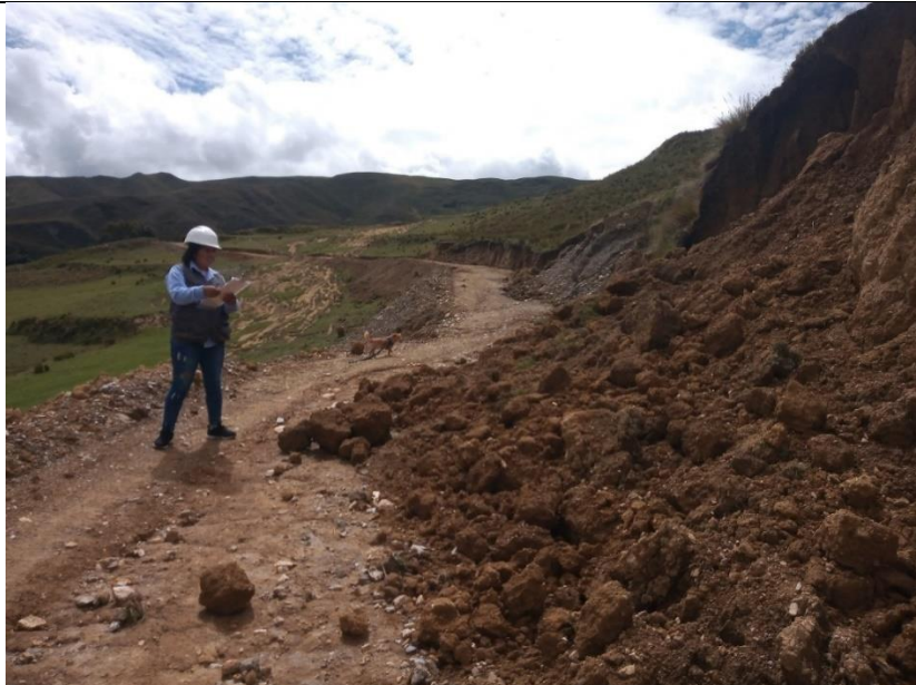
Foto 14. Deslizamiento de talud
