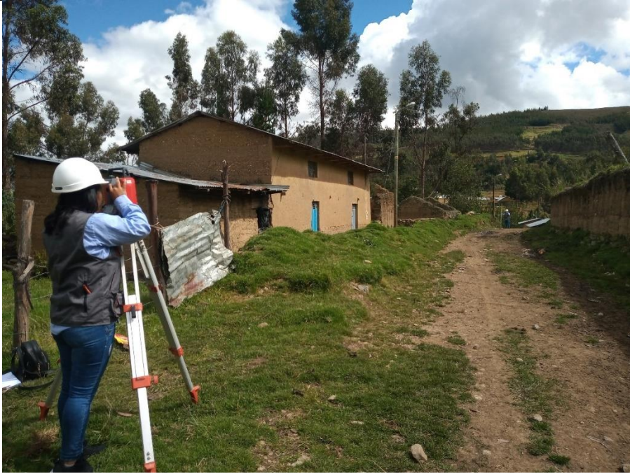
Descripción: toma de los puntos en la progresiva 2+002km del camino
