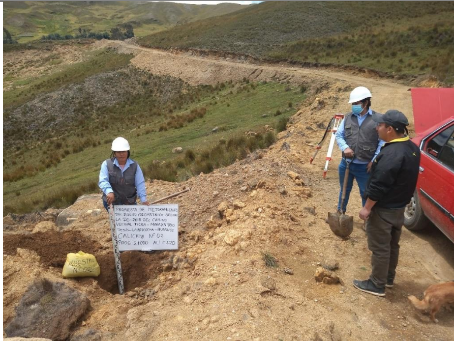
Foto 21. Extracción de las muestras de la calicata
