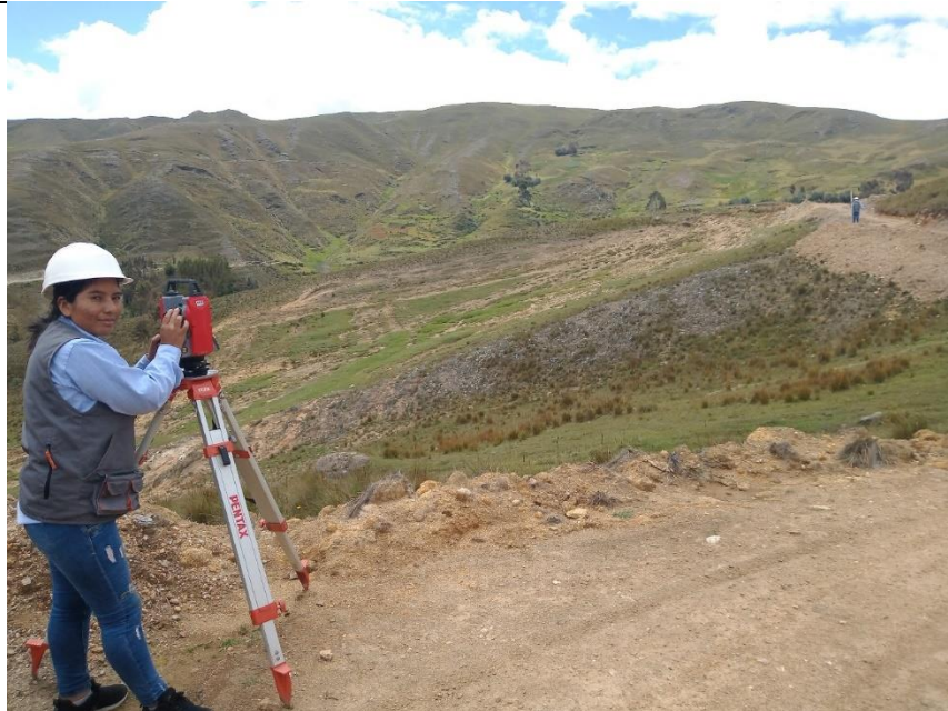
Descripción: se hizo el registro de puntos en la progresiva 8+560km
