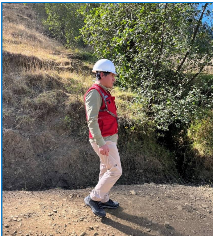
Recorrido del tramo Progresiva KM: 2+380
