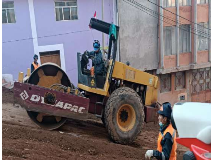
Figura 10. Movimiento de Tierra en subrasante
