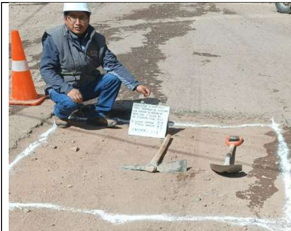
Imagen 01: Delimitación y marcación de nuestra calicata N°1
