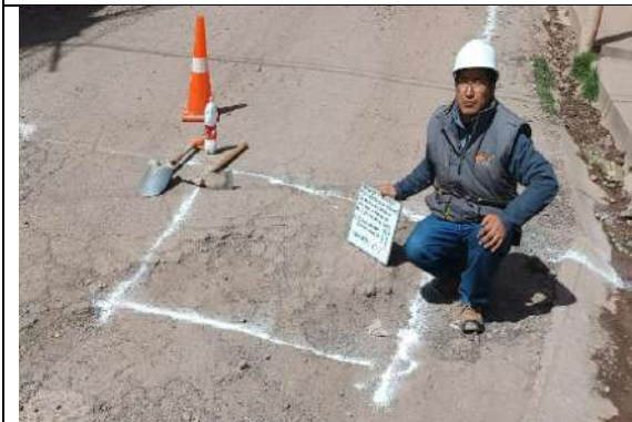
Imagen 03: Delimitación y marcación de nuestra calicata N°3
