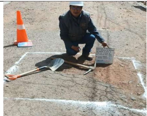
Imagen 02: Delimitación y marcación de nuestra calicata N°2
