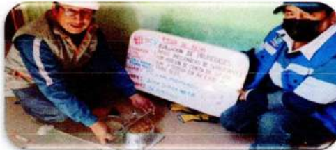
PANEL 17: EJECUCION DE PROCTOR
