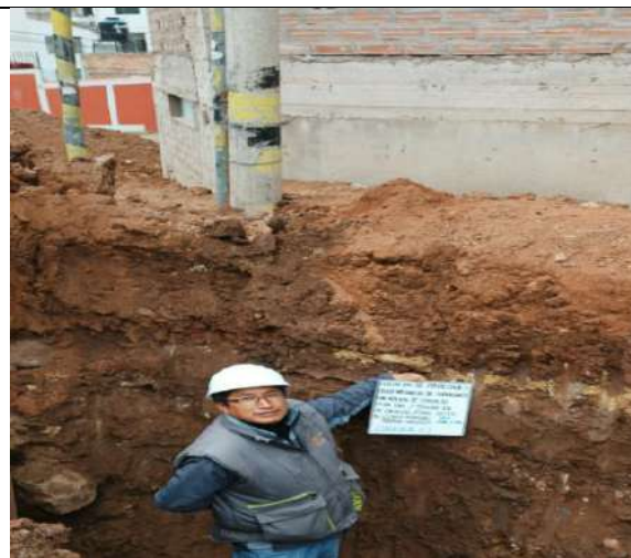
Imagen 06: Sondeo de la calicata N°3
