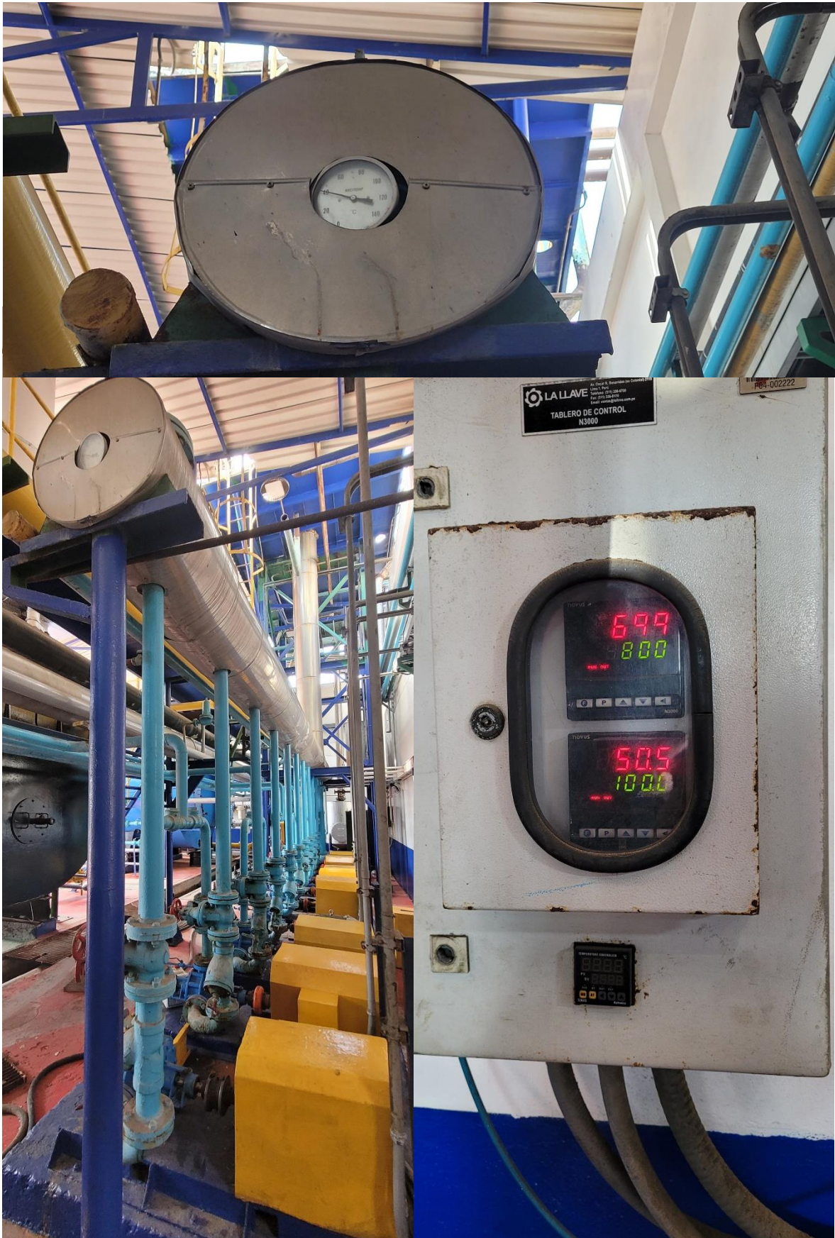
Termómetro y sensor de temperatura para agua de alimentación
