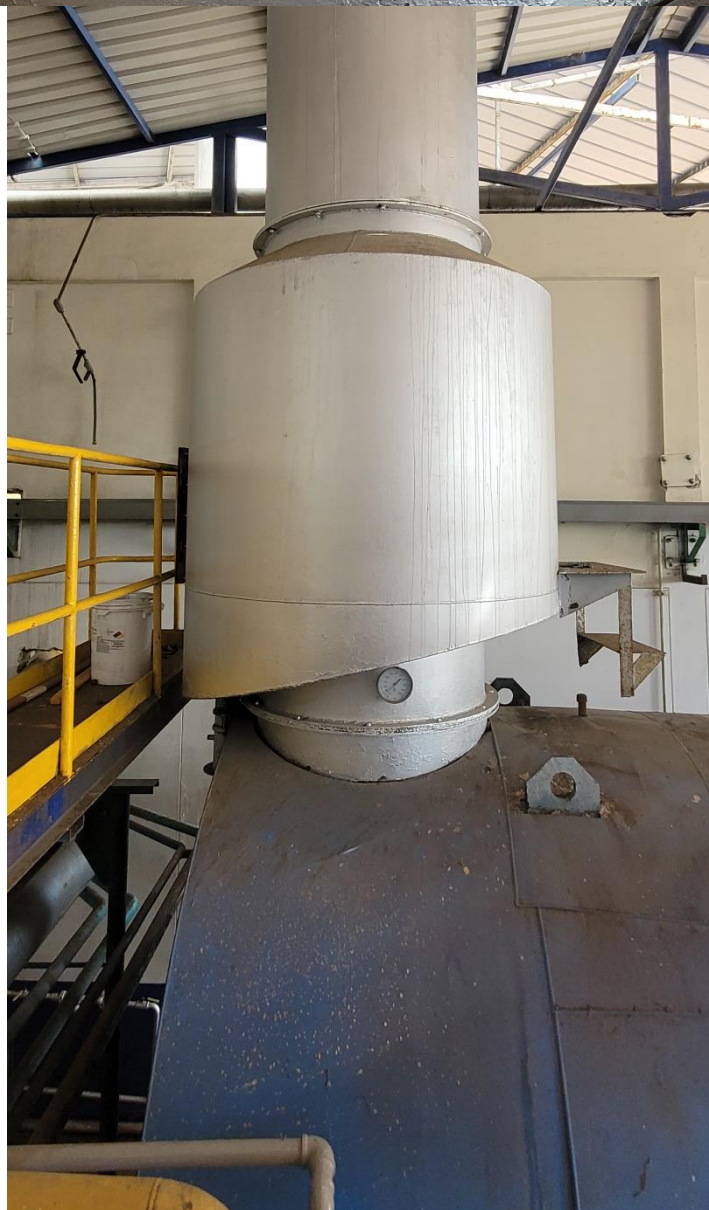
Termómetro para los gases de combustión
