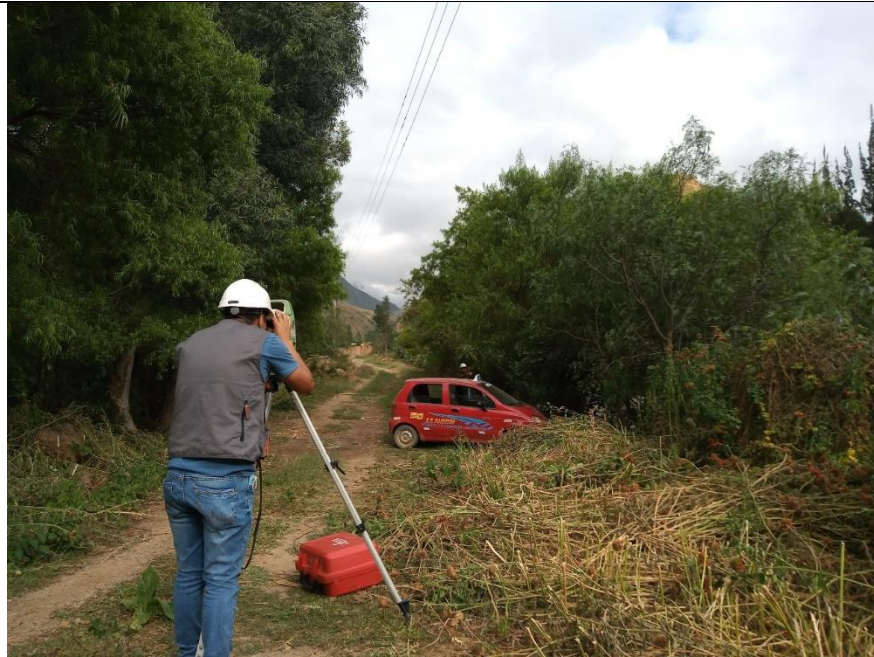
Foto 5. Levantamiento topográfico longitudinal
