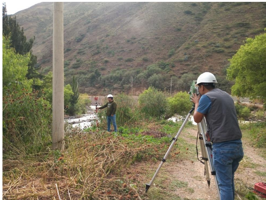
Foto 4. Toma de punto de la cabecera el talud
