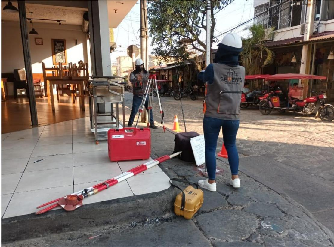
FOTOGRAFÍA 9: Levantamiento topográfico BM-02 Jr. Lamas – Tarapoto, con equipo topográfico nivel topográfico
