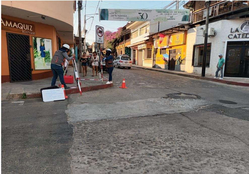
FOTOGRAFÍA 11: Levantamiento topográfico BM-03 Jr. Lamas – Tarapoto, con equipo topográfico estación total marca Leica modelo NA730
