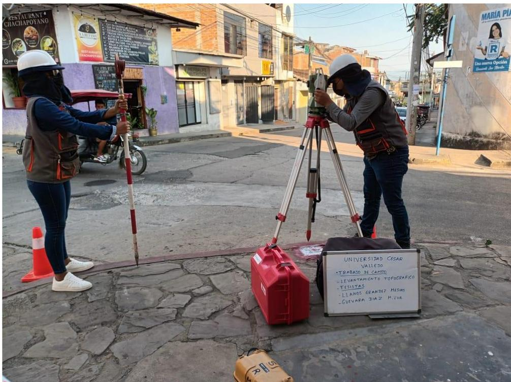
FOTOGRAFÍA 12: Levantamiento topográfico BM-03 Jr. Lamas – Tarapoto, con equipo topográfico estación total marca Leica modelo NA730
