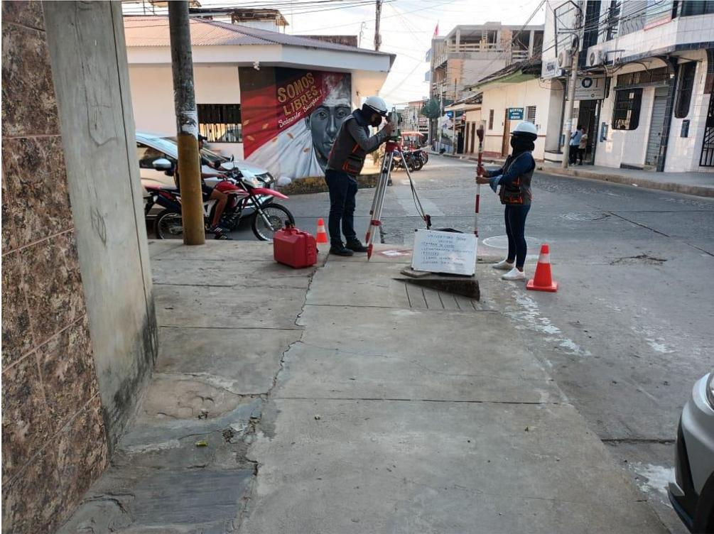
FOTOGRAFÍA 7: Levantamiento topográfico BM-01 Jr. Lamas – Tarapoto, con equipo topográfico estación total marca Leica modelo NA730
