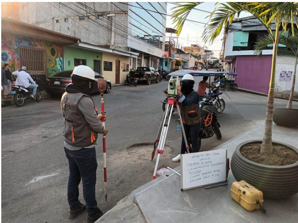
FOTOGRAFÍA 16: Levantamiento topográfico BM-04 Jr. Lamas – Tarapoto, con equipo topográfico estación total marca Leica modelo NA730
