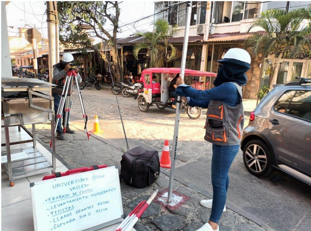
FOTOGRAFÍA 8: Levantamiento topográfico BM-02 Jr. Lamas – Tarapoto, con equipo topográfico nivel topográfico
