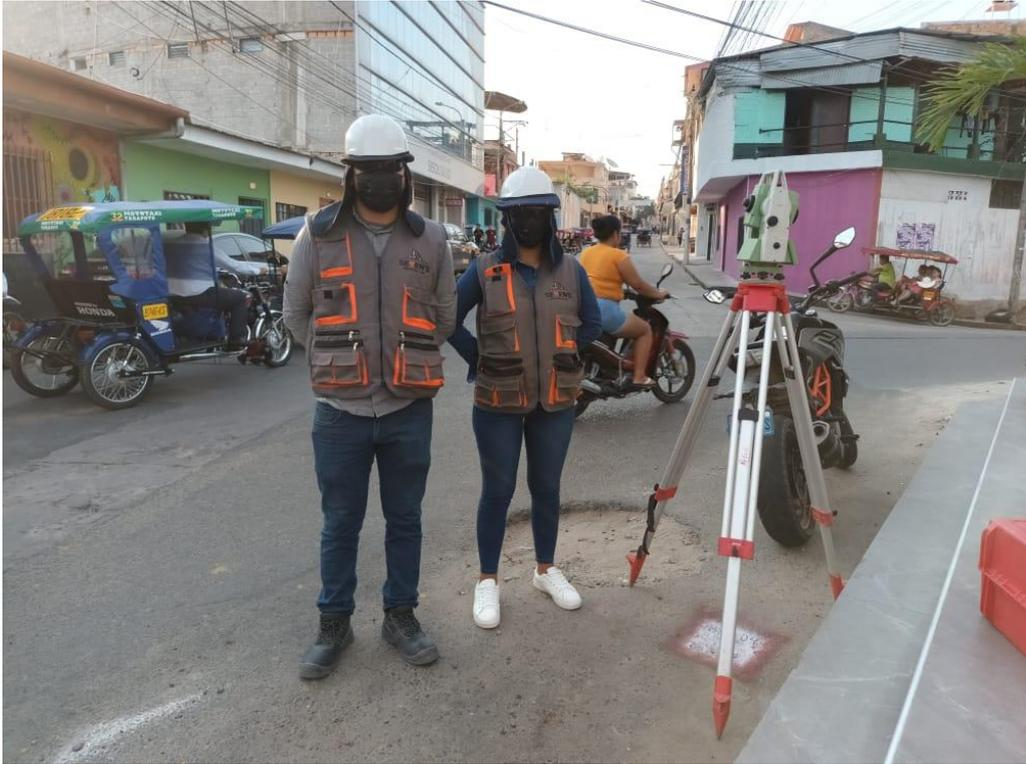
FOTOGRAFÍA 15: Levantamiento topográfico BM-04 Jr. Lamas – Tarapoto, con equipo topográfico estación total marca Leica modelo NA730
