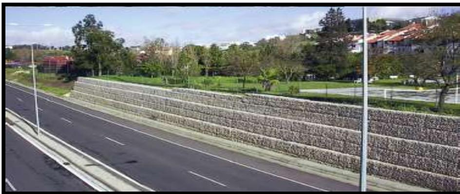
Figura 3. Muro de Gaviones, Recuperado de Bianchini Ingeniero.
