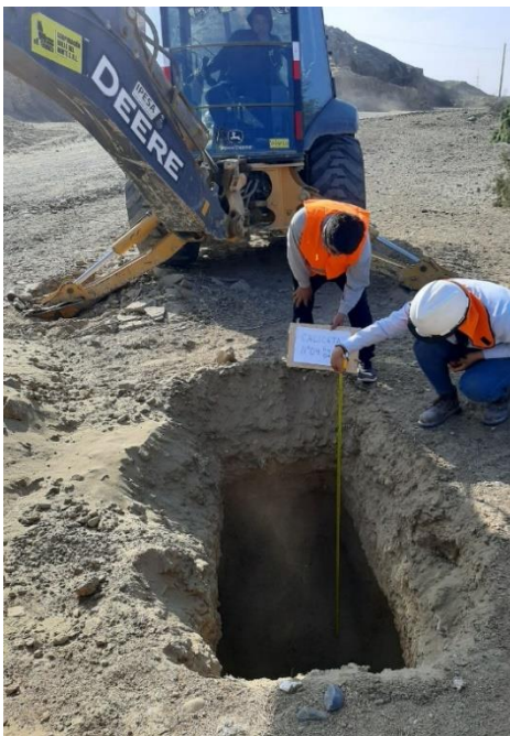
Calicata N°04 Prog. 0+750
