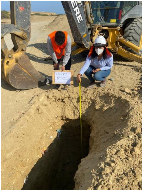
Calicata N°03 Prog. 0+500
