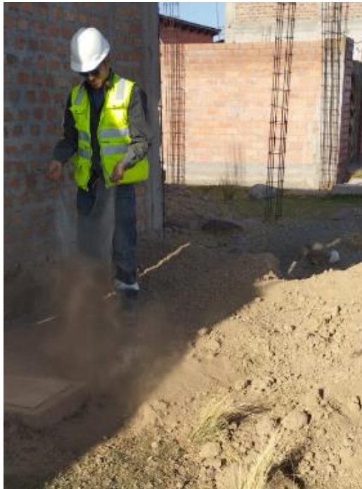
Fotografía 19: Tamizado del suelo para elaborar adobes.
