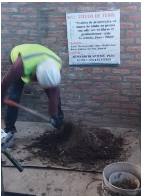
Fotografía 21: Mezclado del suelo con las fibras
