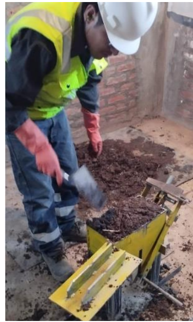
Fotografía 22: Llenado de la prensa manual con material.
