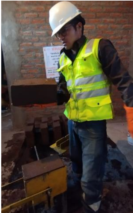
Fotografía 23: Retirado de un adobe compactado en la prensa manual.
