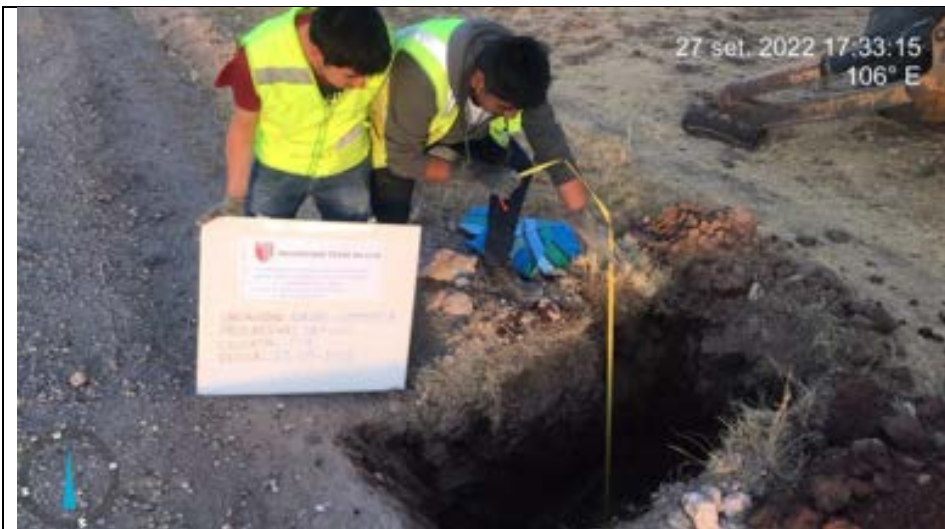
Imagen 10: Se observa la medida de la calicata N° 02 a 1.50 m de profundidad.
