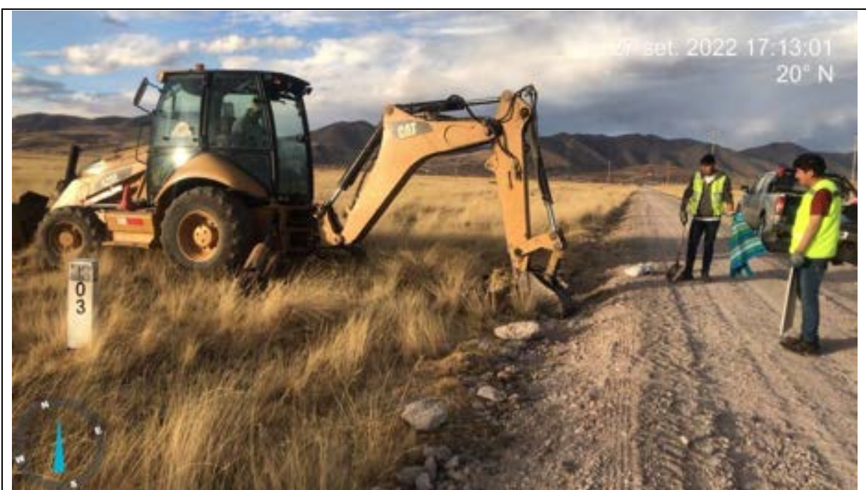
Imagen 15: Se observa la excavación de la calicata 03.
