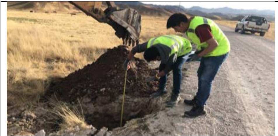
Imagen 22: Se observa la medida de la calicata N° 04 a 1.50 m de profundidad.
