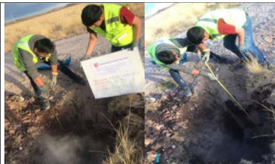
Imagen 16: Se observa la medida de la calicata N° 03 a 1.50 m de profundidad.
