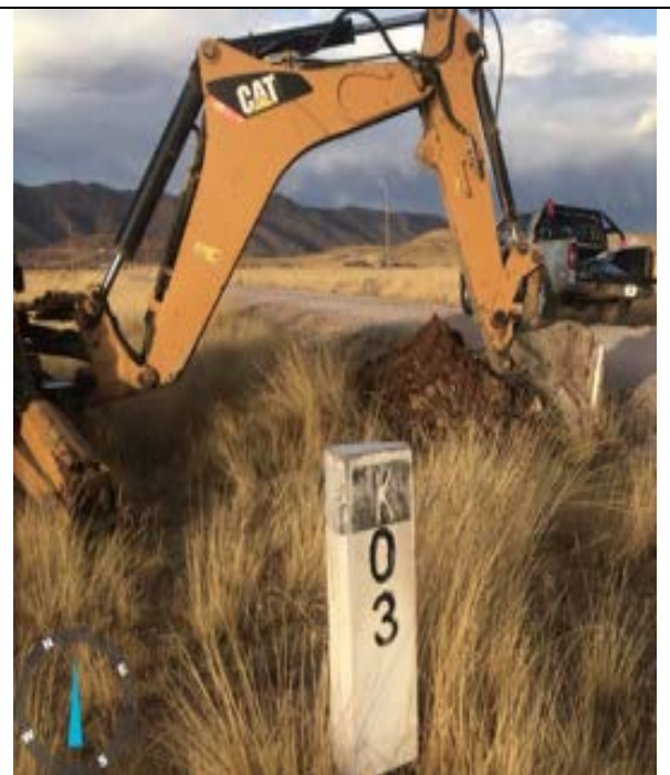
Imagen 14: Se observa la excavación de la calicata 03.
