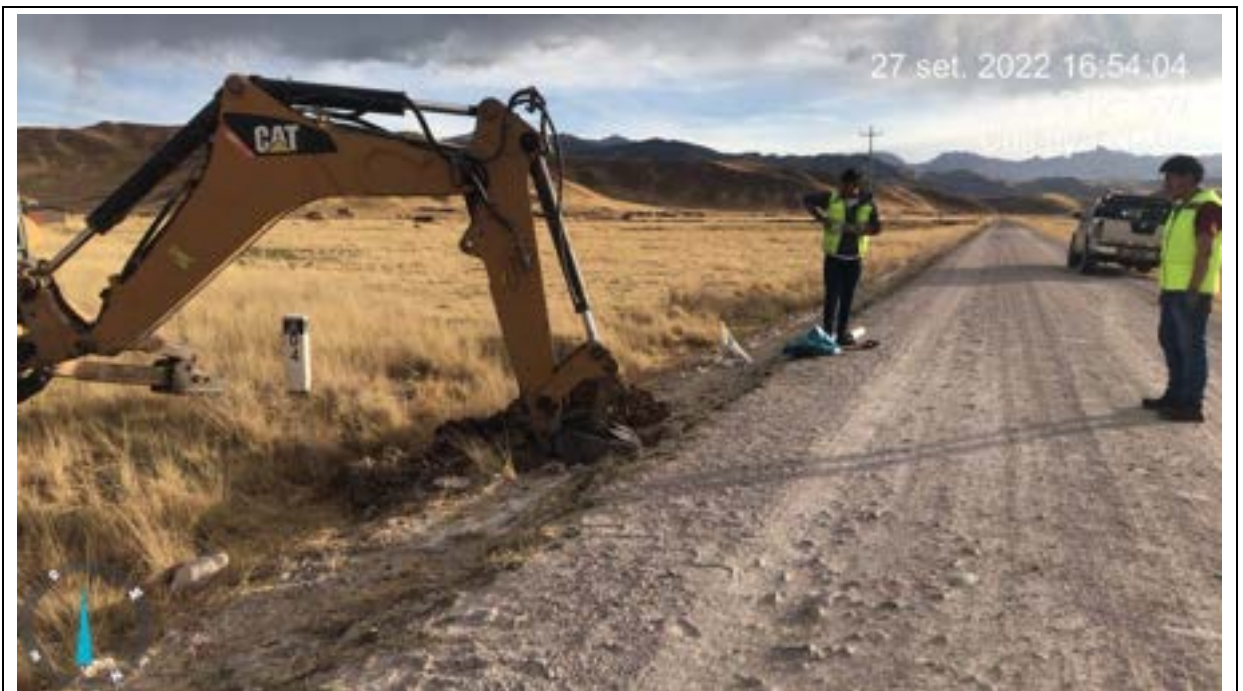
Imagen 21: Se observa la excavación de la calicata 04.
