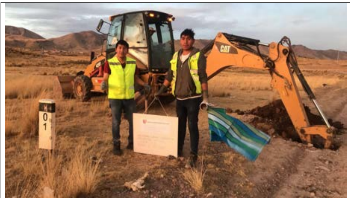
Imagen 3: Se observa la excavación de la calicata 01.
