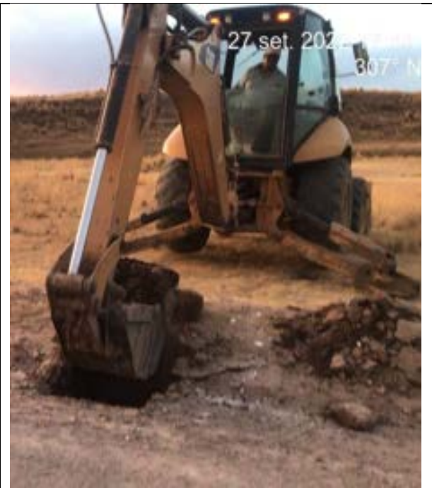
Imagen 2: Se observa la excavación de la calicata 01.
