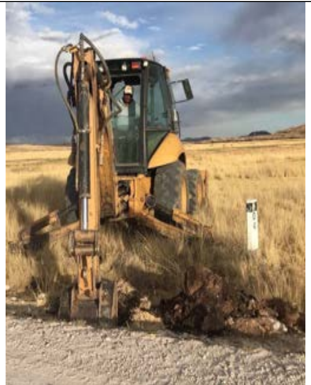
Imagen 20: Se observa la excavación de la calicata 04.
