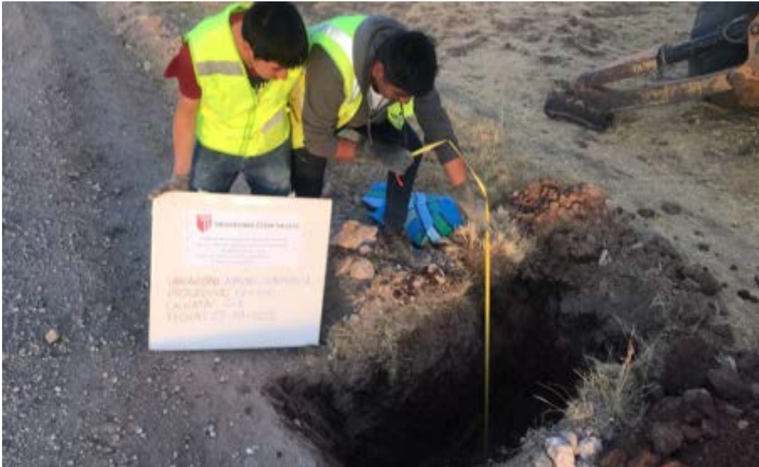
Figura 24. Calicata del camino vecinal
