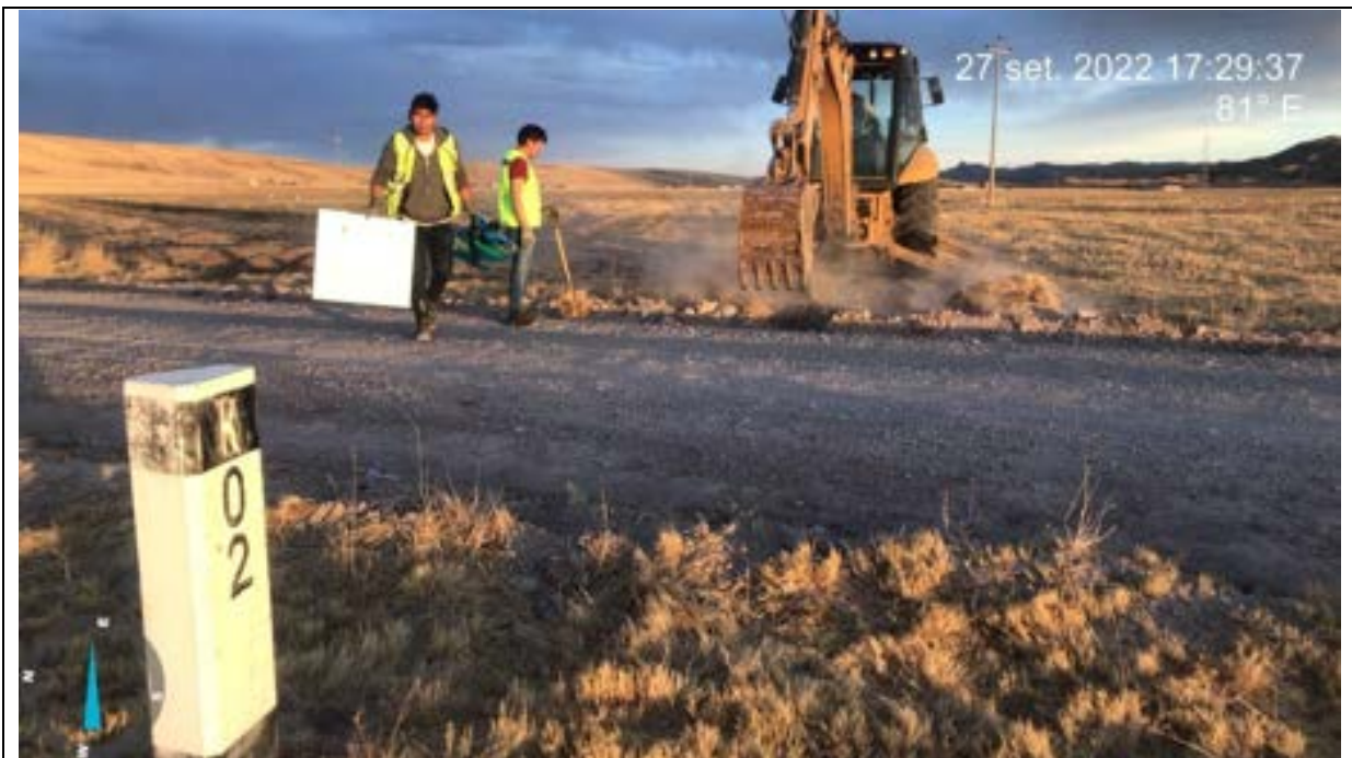
Imagen 9: Se observa la excavación de la calicata 02.
