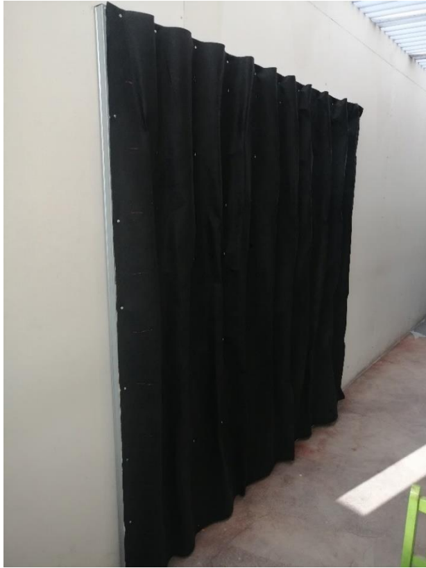
Foto 3: Instalación de capas de geotextil
