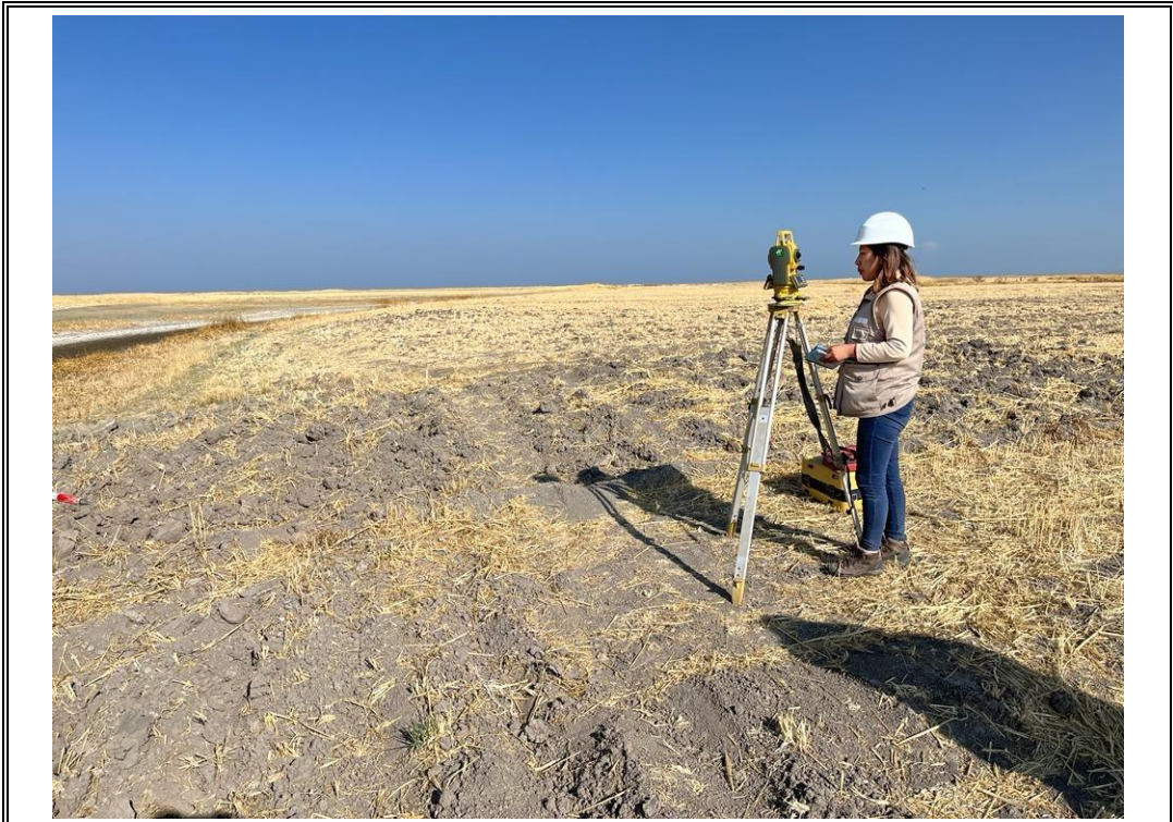
Fotografía N°13: Levantamiento topográfico del canal de derivación.
