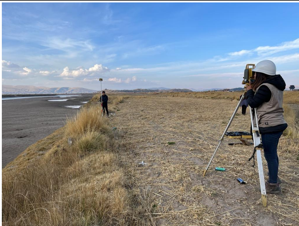
Fotografía N°4: Levantamiento topográfico con estación total en un tramo del río Ramis.
