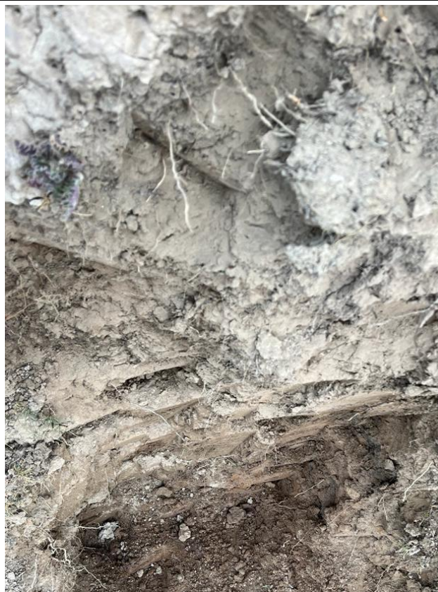
Fotografía N°10: Calicata en la ubicación de la bocatoma para el estudio de suelos, además del calculo de su capacidad portante.
