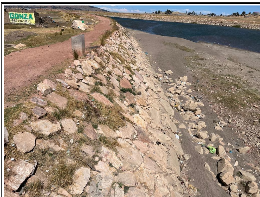
Fotografía N°17: Defensa ribereña en el río Ramis, cerca al puente Ramis.
