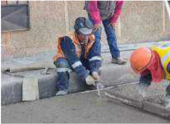
Figura 07: en la imagen se aprecia la insercion de la platina metalica para generar la junta de contraccion en el pavimento rigido, en el Jr. Umachiri de la localidad de Ayaviri, Provincia de Melgar.
