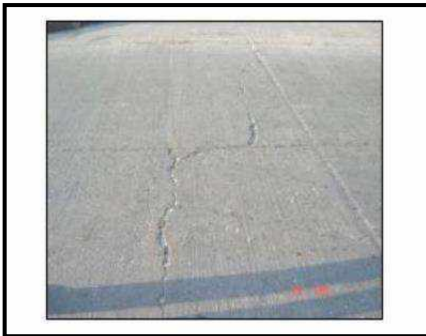
Figura 04. Grietas transversales
