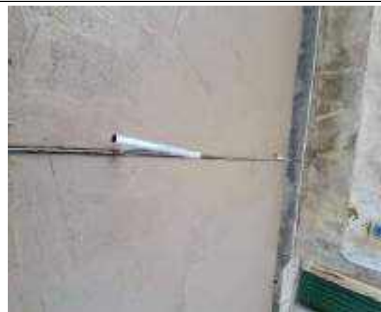
Figura 09: en la imagen se aprecia la insercion de la platina metalica para generar la junta de contraccion en el pavimento rigido, en el Jr. Umachiri de la localidad de Ayaviri, Provincia de Melgar.
