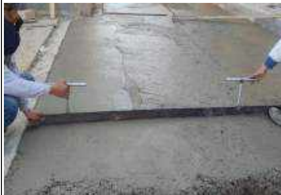
Figura 08: en la imagen se aprecia la insercion de la platina metalica para generar la junta de contraccion en el pavimento rigido, en el Jr. Umachiri de la localidad de Ayaviri, Provincia de Melgar.
