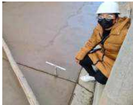
Figura 10: En la imagen se muestra el proceso de vaciado de concreto para las losas del pavimento rigido del Jr. Umachiri, se puede verificar tambien la insercion de las platinas metalicas.
