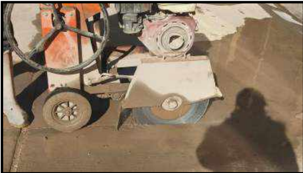
Figura 02. Aserrado para juntas de contracción en pavimento.
