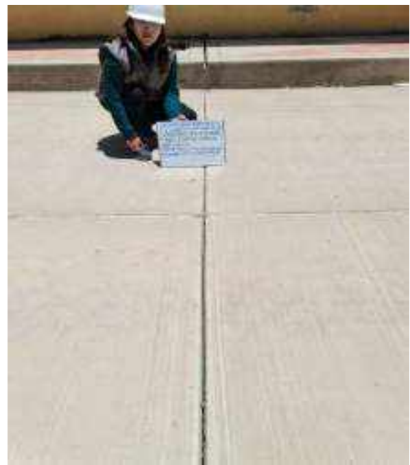
Figura 15: En la imagen se aprecia el resultado de la insercion de platinas metalicas en el pavimento rigido, para la ejecucion de las juntas de contraccion, el cual a la fecha de la ejecucion no presento ninguna falla.
