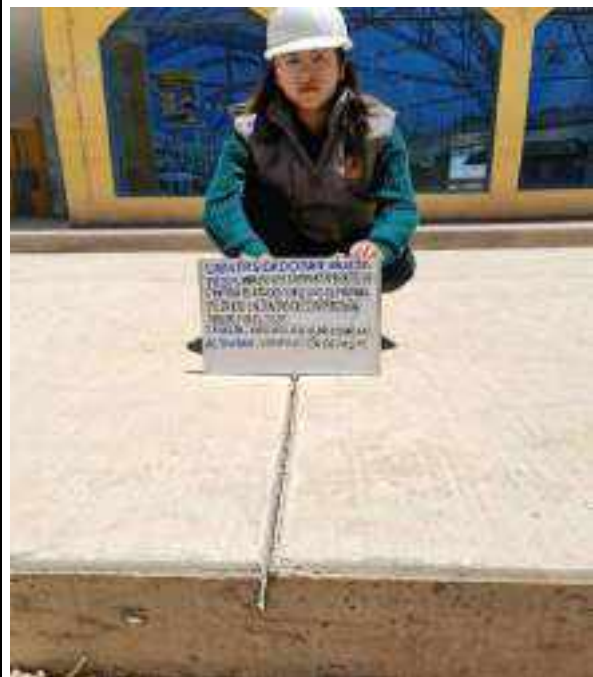
Figura 10: En la imagen se aprecia el resultado de la insercion de platinas metalicas en el pavimento rigido, para la ejecucion de las juntas de contraccion, el cual a la fecha de la ejecucion no presento ninguna falla.
