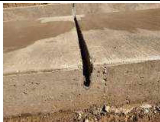
Figura 10: En la imagen se muestra el proceso de vaciado de concreto para las losas del pavimento rigido del Jr. Umachiri, se puede verificar tambien la insercion de las platinas metalicas.
