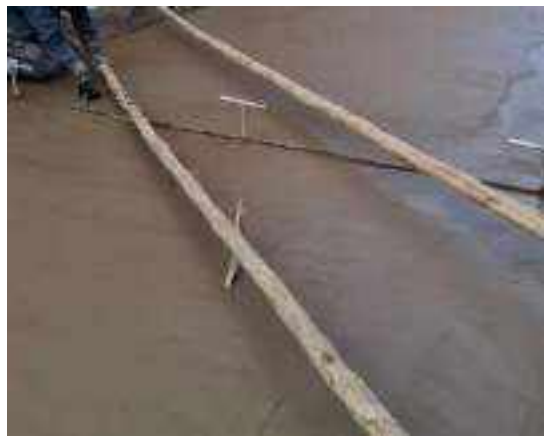
Figura 09: en la imagen se aprecia la insercion de la platina metalica para generar la junta de contraccion en el pavimento rigido, en el Jr. Umachiri de la localidad de Ayaviri, Provincia de Melgar.
