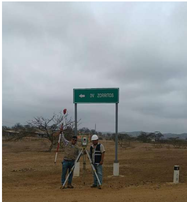
Foto N° 07: Utilizando el equipo completo para el levantamiento topográfico.
