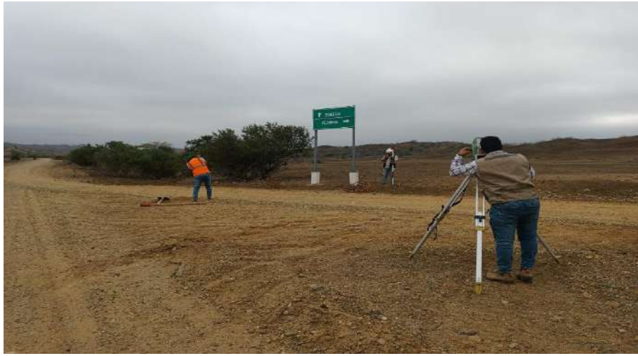
Foto N° 06: Realizando del levantamiento topográfico en la vía El Tubo-Pedregal
