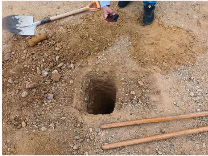
Foto N° 08: Excavación de la C-1
