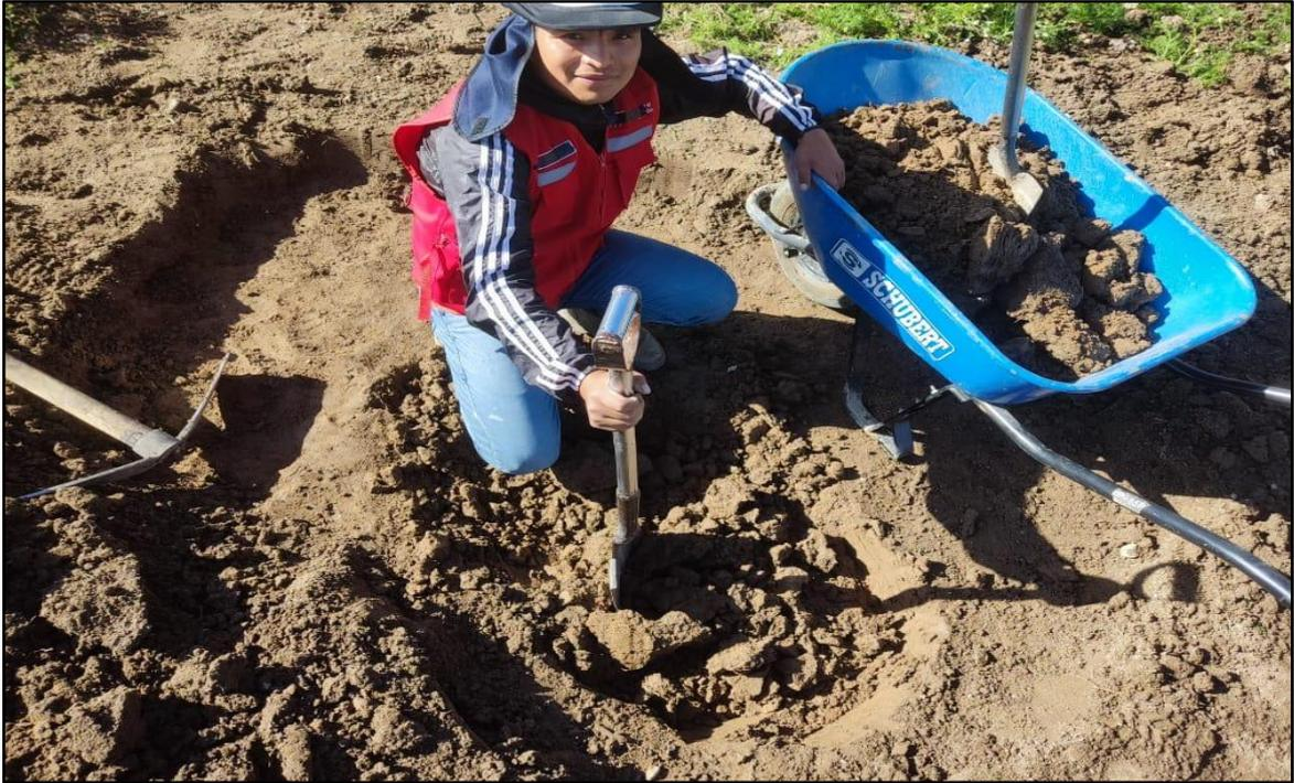
**Fotografía N°:** Se procede con la extracción de tierra arcillosa, teniendo en cuenta la cantidad aproximada por unidad de adobe correspondiente a 15kg, para una población total de 96 unidades, se extrajó 1,460kg considerando el desperdicio.
