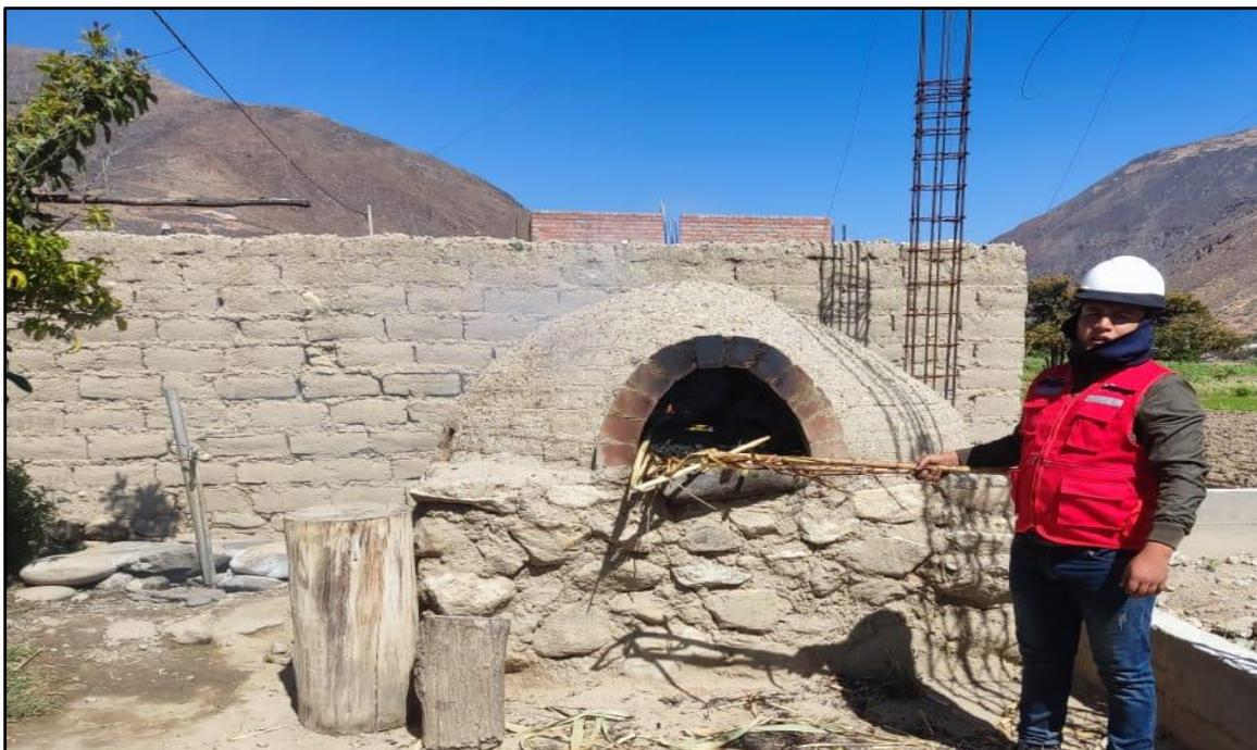
**Fotografía N°:** Calcinación del carrizo utilizando un horno artesanal.
