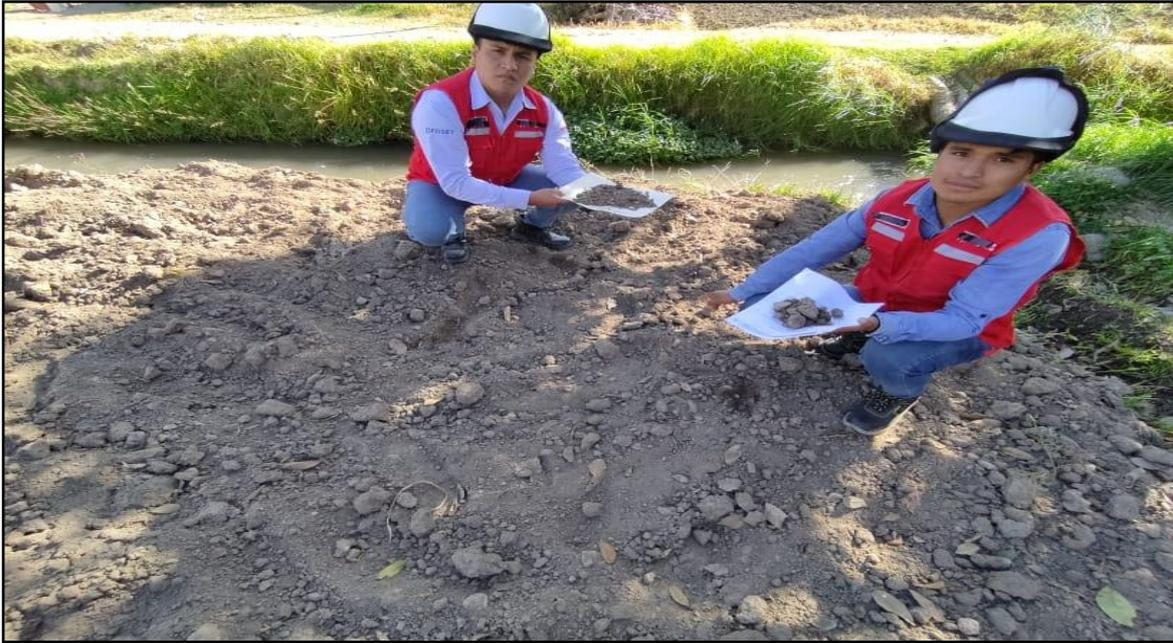
**Fotografía N°01:** Se inicia con la selección de la tierra para la elaboración de adobes (tierra arcillosa).
