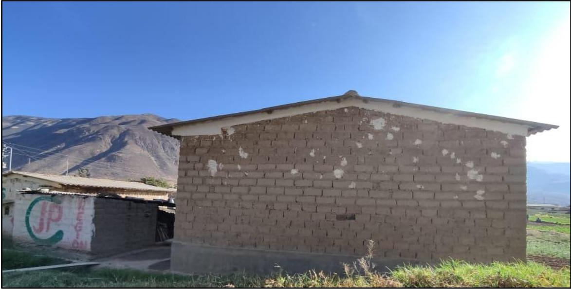
**Fotografía N°:** Contrarrestando con la investigación, se muestra la continuidad de la construcción con bloques de adobe en la localidad de Cayasbamba.
