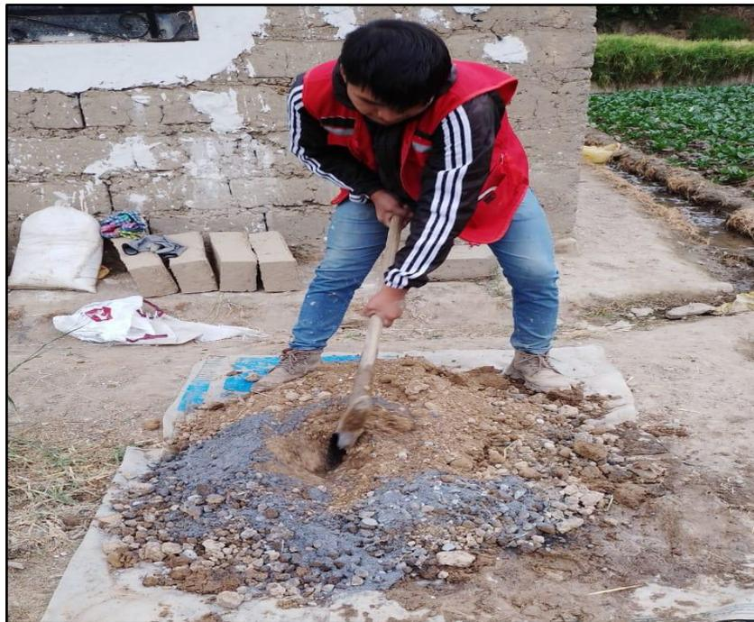
**Fotografía N°:** Preparación de la mezcla para la elaboración del adobe estabilizado con solución porcentual de ceniza de carrizo y confitillo.
