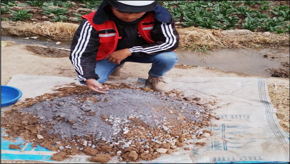
**Fotografía N°:** Incorporación de ceniza de carrizo y confitillo para la elaboración del adobe estabilizado.
