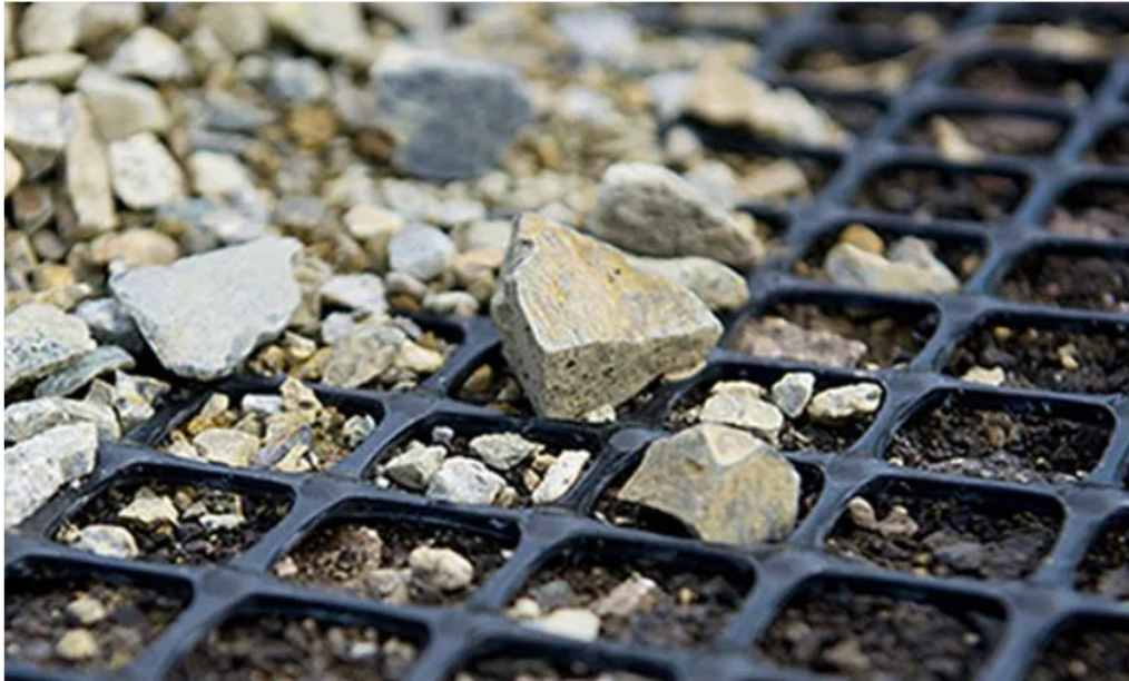
Figura 13: Estabilización con geomallas
