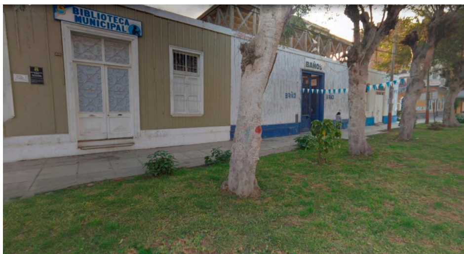
Biblioteca Municipal deteriorado y mal uso
